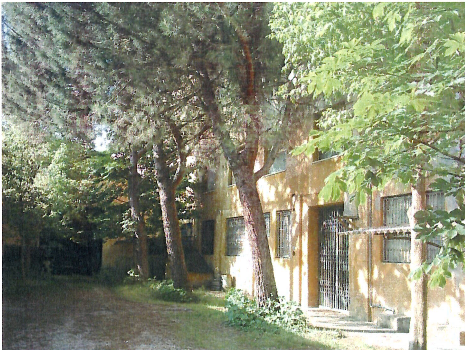
cortile interno ed edifici confinanti
