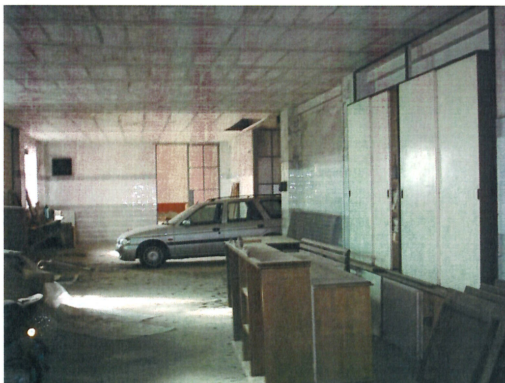
interno del capannone principale / 2
