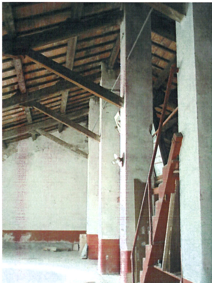
interno del capannone principale / 1
