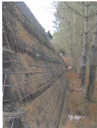
3. I sistemi portanti più ricorrenti saranno: le terre armate con sistemazioni a siepi e cespugli, i gabbioni rinverditi, le palificate vive.
