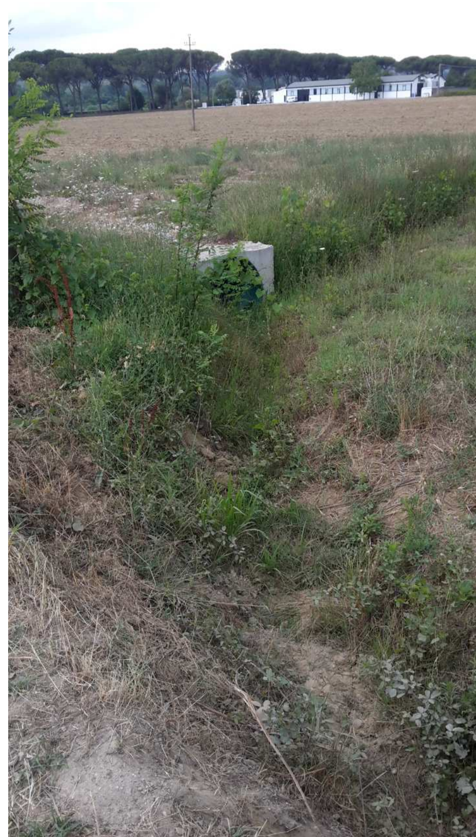
Foto nuova tubazione
