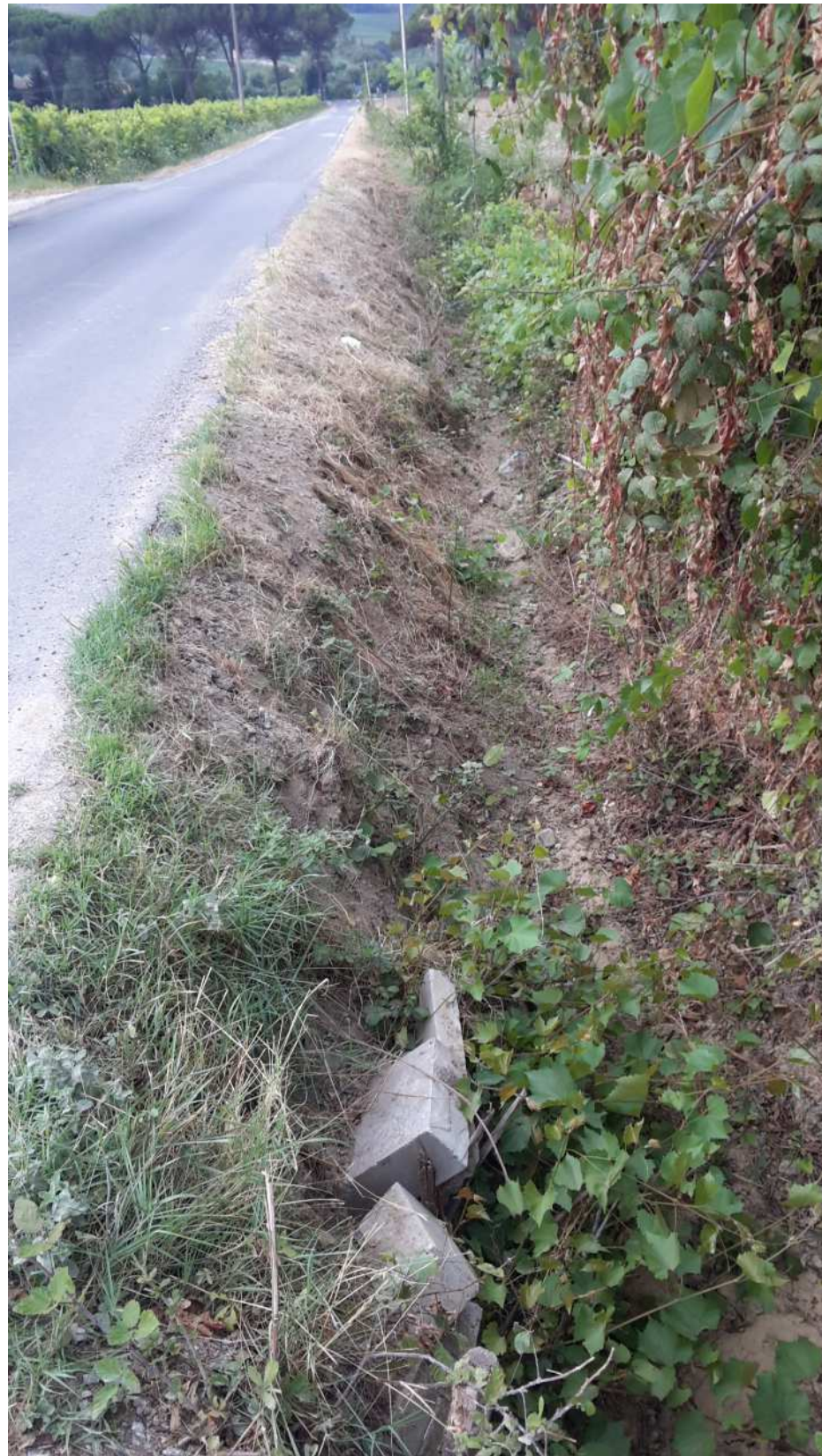
Foto scarpata e fossa
