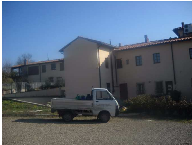
FOTO 4 - Rif. A - veduta parziale lato Nord
