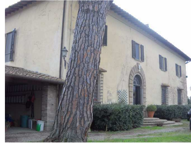
FOTO 3- Rif. A e Rif.B-fronte principale e annesso a sx
