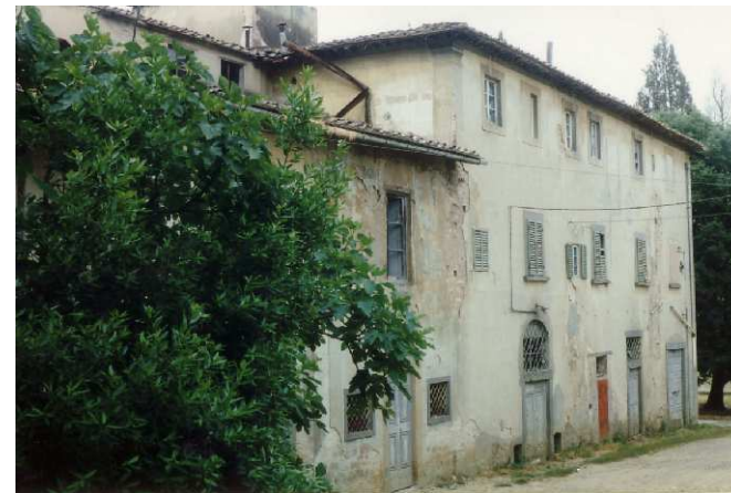
FOTO 5 - Rif. A - Il prospetto settentrionale
