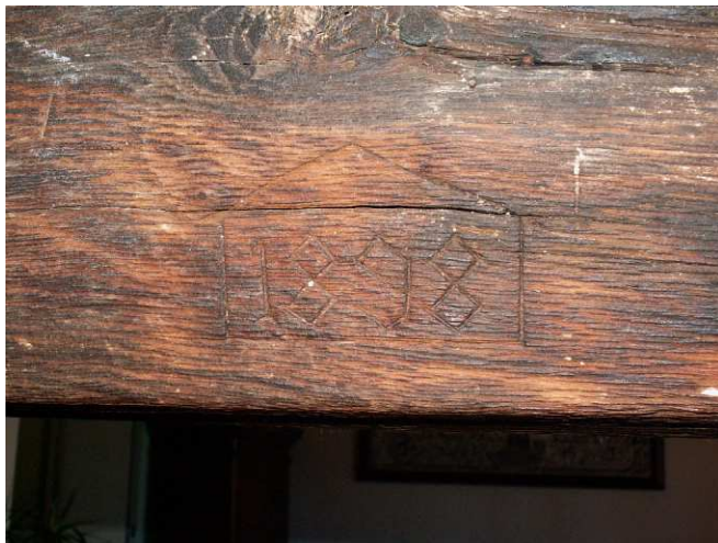
FOTO 4 - Rif. A - interno, architrave del camino con datazione
