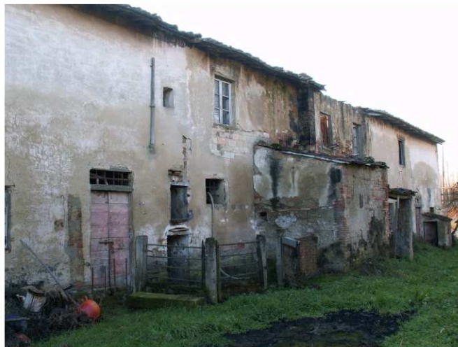
FOTO 4 - Rif. A - veduta parziale del prospetto retro
