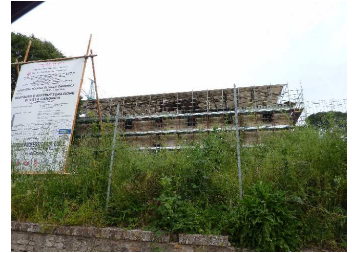
FOTO 13 - Rif. A - Lo stato attuale della villa con il ponteggio per la ristrutturazione
