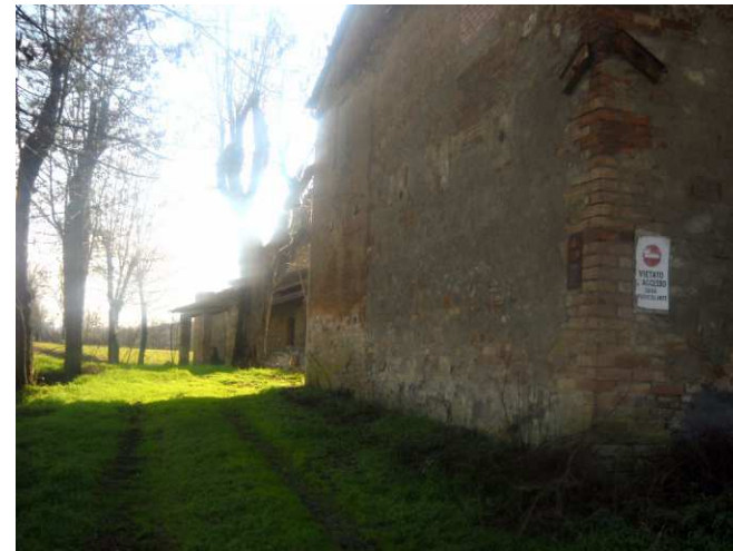
FOTO 5 - Rif. A - fronte laterale e, in secondo piano, l'edificio Mulinaccio 2
