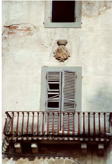
FOTO 10 - Rif. A - Particolare del balcone sul prospetto principale
