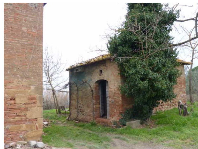
FOTO 11 - Rif. C - prospetto principale dell'edificio adibito a forno con annesso porcilaie sul lato sx
