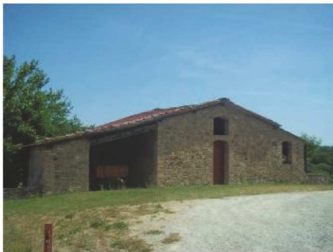
FOTO 7 - Prospetto del fronte - edificio B
