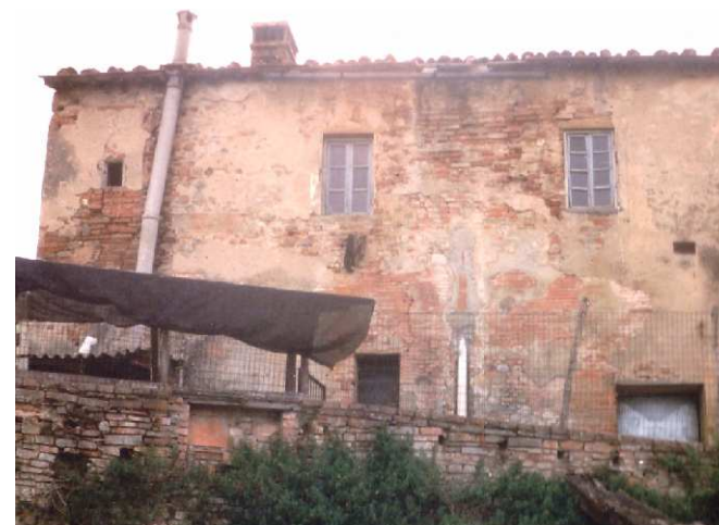
FOTO 2 - Rif. A - Il prospetto principale
