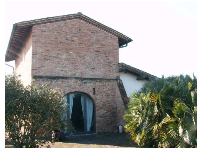
FOTO 8 - Rif. C - veduta del fronte con l'ingresso
