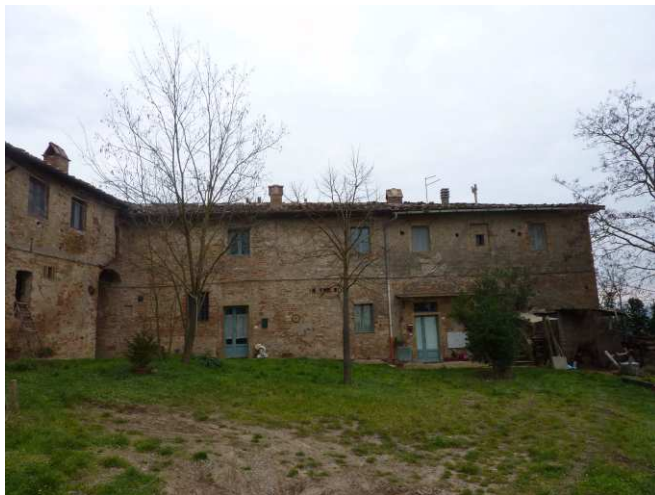
FOTO 4 - Rif. A - prospetto del braccio nord
