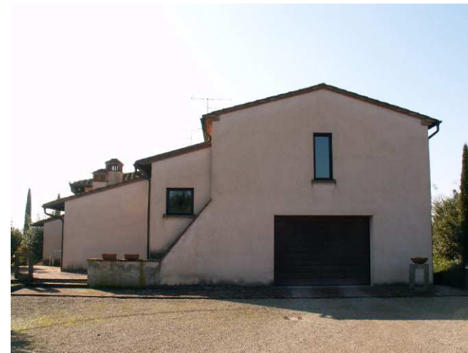
FOTO 6 - Rif. B - prospetto lato Nord
