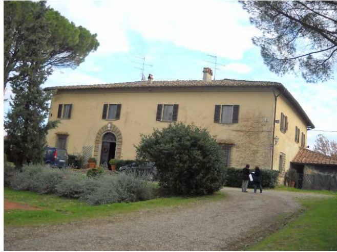
FOTO 1 - Rif. A - prospetto principale
