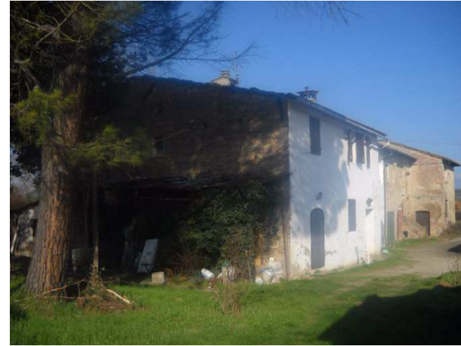
FOTO 3 - Rif. A - prospetto frontale
