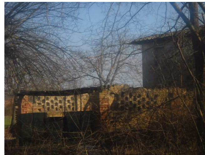
FOTO 9 - Rif. E - un volume addossato sul retro
