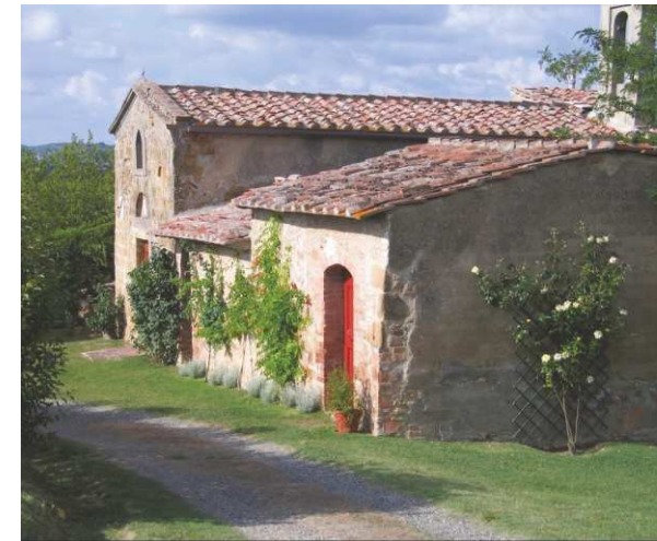
FOTO 6 - Cappella e annessi - edificio A
