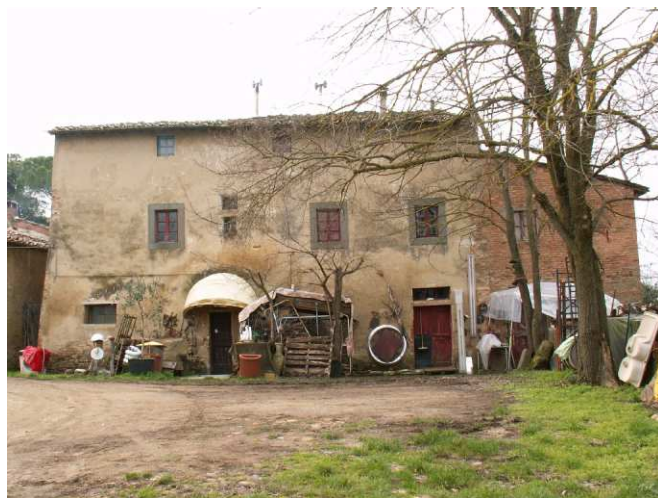
FOTO 4 - Rif. A - Veduta di parte del fronte principale
