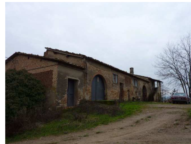
FOTO 9 - l'ala nord vista da est
