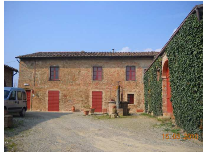
FOTO 2 - Rif. A - prospetto principale con vista del pozzo
