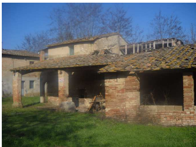
FOTO 4 - Rif. A - veduta laterale dei volumi annessi
