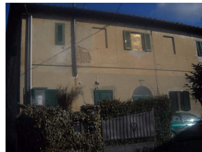
FOTO 3 - Rif. A - veduta lato Sud-Ovest
