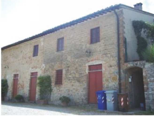
FOTO 1 - Prospetto principale - edificio A
