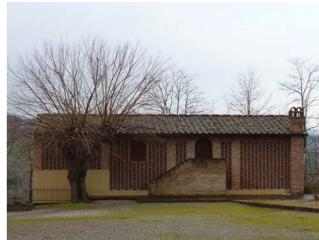
FOTO 5 - Rif. B - prospetto laterale
