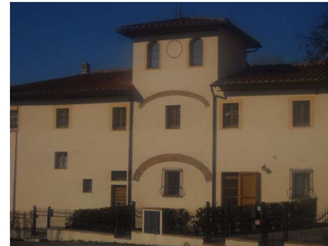
FOTO 6 - Rif. A - particolare della torretta
