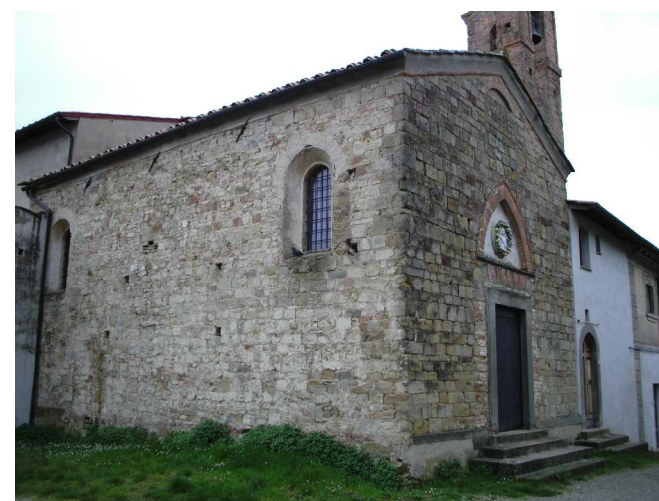
FOTO 3 - facciata della chiesa - edificio A'
