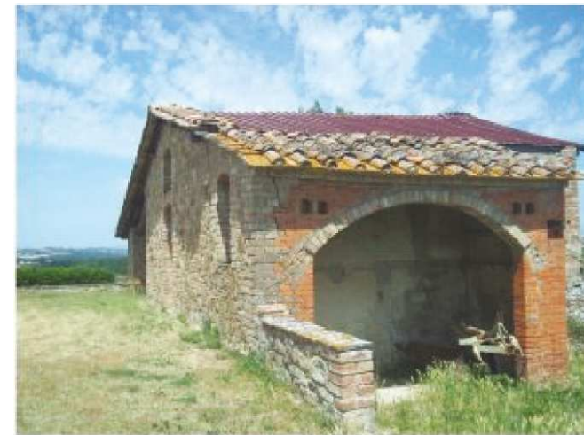
FOTO 8 - Prospetto laterale - edificio B
