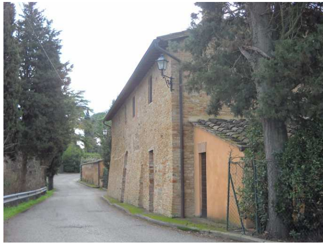
FOTO 1 - prospetto lungo strada
