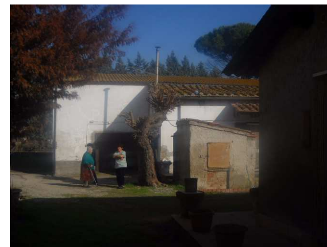
FOTO 6 - Rif. A - veduta degli annessi e del pozzo
