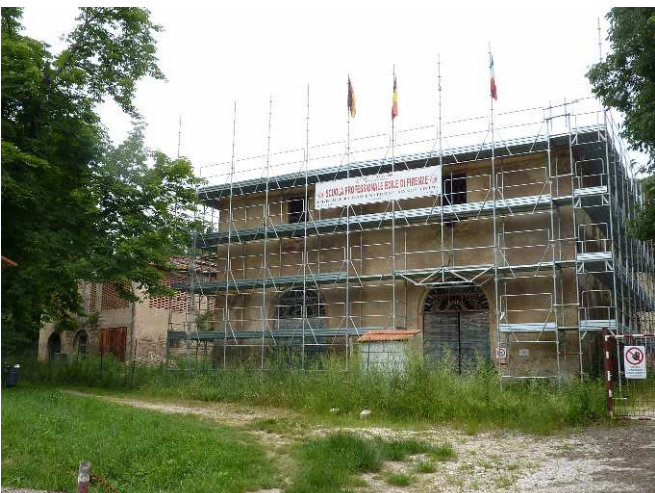
FOTO 7 - Rif. A - Il prospetto di foto 1 allo stato attuale, con l'impalcatura per la ristrutturazione
