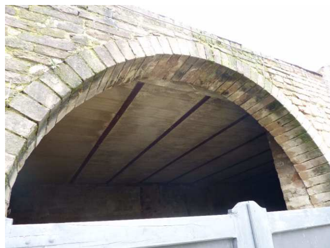
FOTO 11 - Rif. A - solaio di copertura a piano terra
