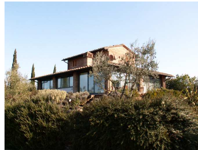
FOTO 9 - Rif. C - veduta dal giardino
