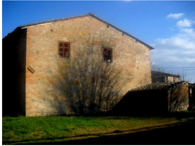
FOTO 1 - Rif. A - Prospetto laterale est
