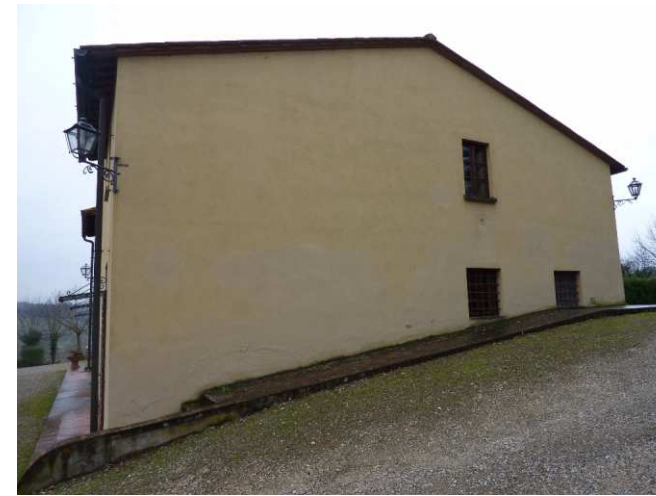
FOTO 3 - Rif. A - prospetto laterale Nord
