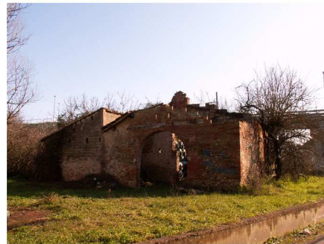
FOTO 5 - Rif. B - veduta del fronte
