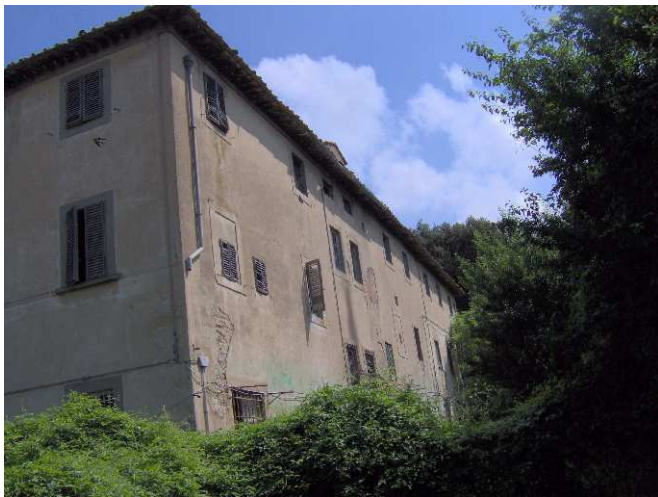
FOTO 4 - Rif. A - L'angolo sud ovest della villa
