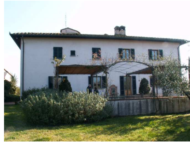
FOTO 2 - Rif. A - prospetto lato Ovest
