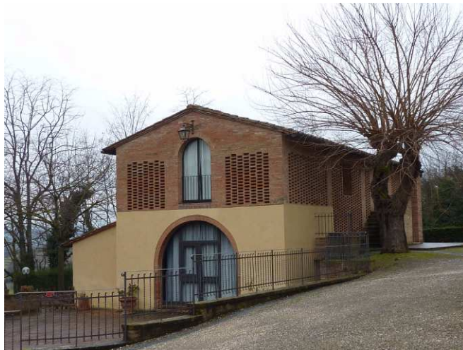
FOTO 4 - Rif. B - veduta dell'ingresso
