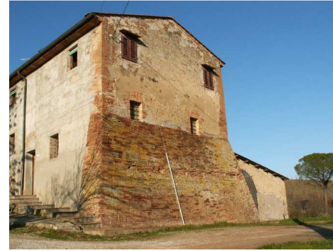
FOTO 3 - Rif. A - prospetto di valle con barbancane
