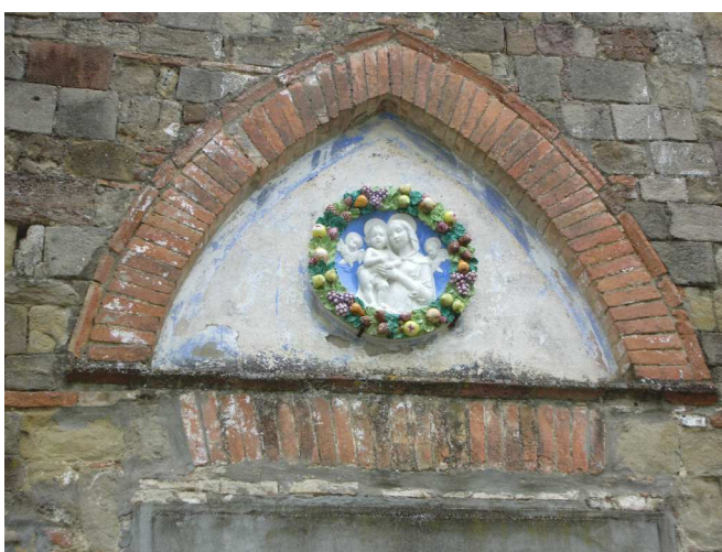
FOTO 4 - Particolare della lunetta del portale - edificio A
