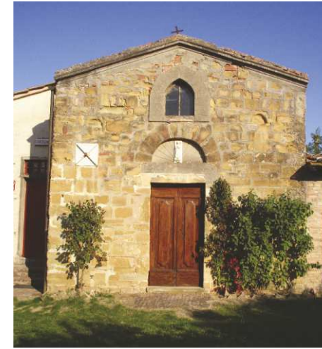
FOTO 3 - Cappella - edificio A
