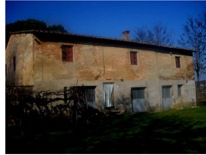
FOTO 3 - Rif. A - il prospetto di ingresso che guarda verso l'edificio del Mulinaccio 2
