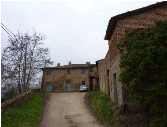
FOTO 1 - Rif. A - il prospetto dalla strada di accesso
