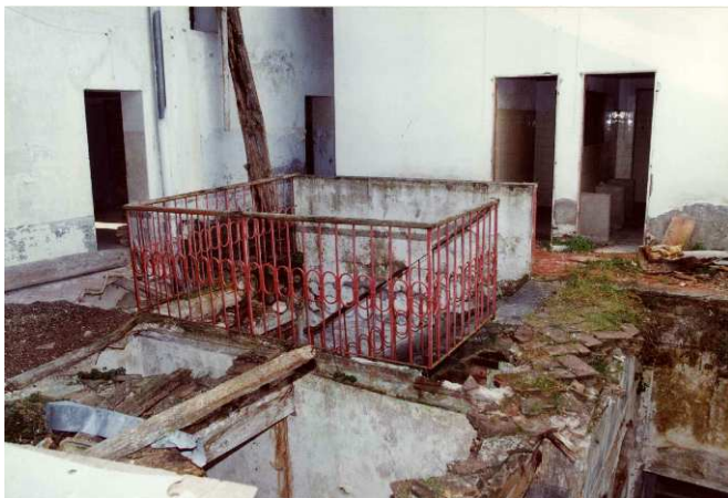
FOTO 7 - Rif. A - La scala che conduce allo spazio interno della piccolissima corte
