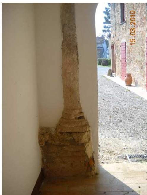
FOTO 10 - Rif. A - particolare di una colonna in travertino all'interno della muratura del portico
