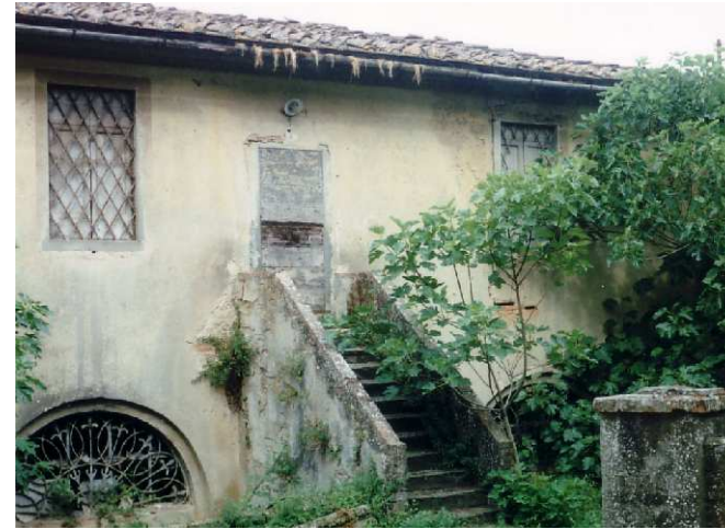
FOTO 2 - Rif. A - Il prospetto principale
