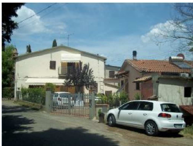
FOTO 1 - Prospetto lungo strada - edifici B e C
