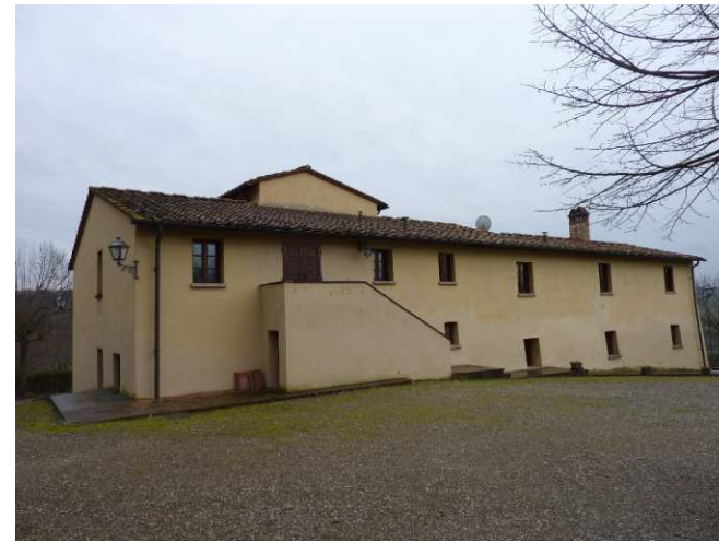
FOTO 2 - Rif. A - prospetto retro
