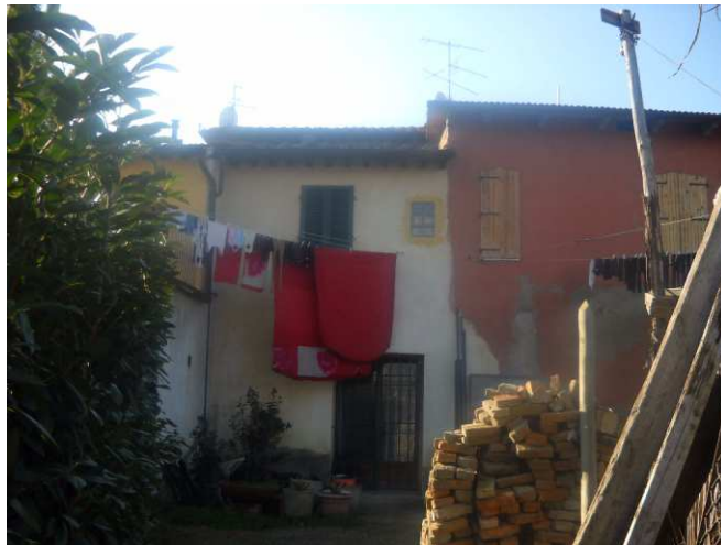
FOTO 4 - Rif. A-B - veduta parziale del prospetto retro
