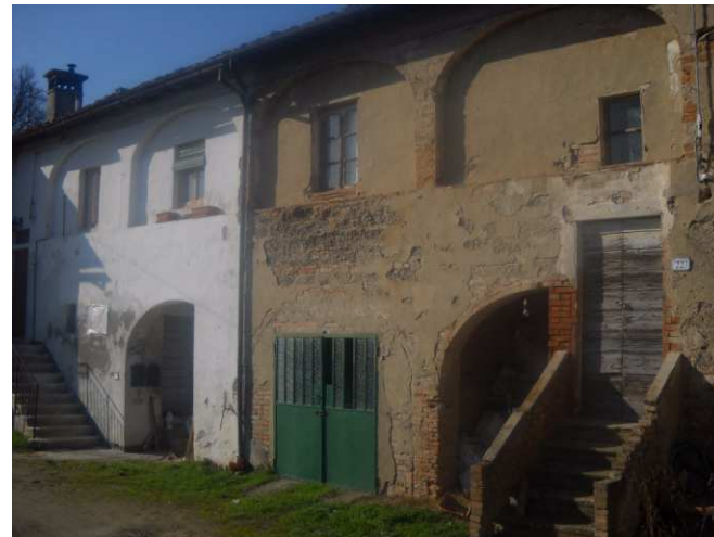
FOTO 5 - Rif. A - particolare del fronte con loggiato
