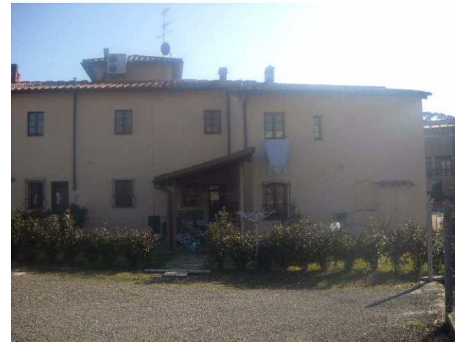
FOTO 5 - Rif. A - veduta parziale lato Nord
