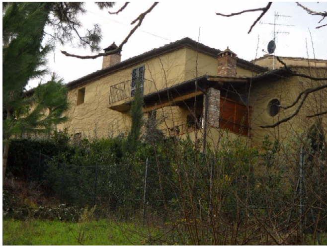
FOTO 4 - Rif. A - retro dell'edificio principale
