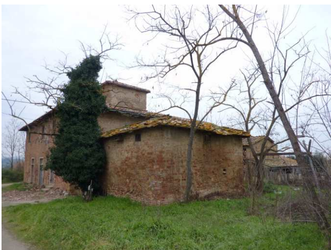
FOTO 10 - Rif. C - il retro dell'edificio adibito a forno
