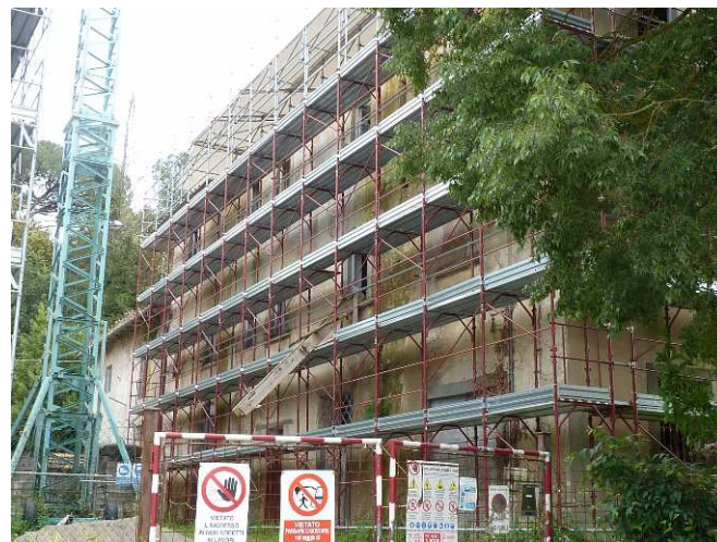
FOTO 14 - Rif. A - Una vista laterale con il ponteggio
