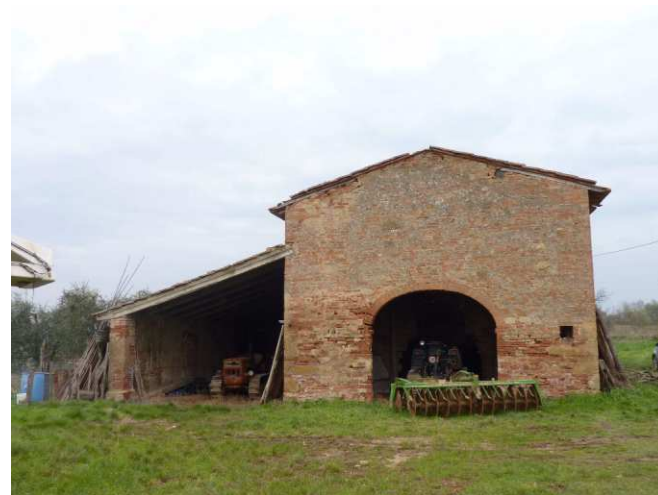
FOTO 5 - Rif. B - Fienile con parata, testata principale
