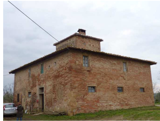
FOTO 2 - Rif. A - prospetto lato sx e retro
