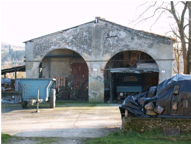
FOTO 4 - Rif. B - veduta del fronte principale
