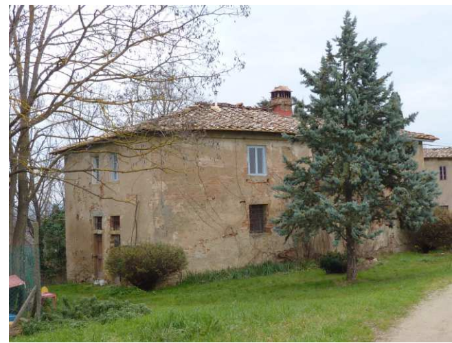
FOTO 2 - Rif. A - prospetto principale
