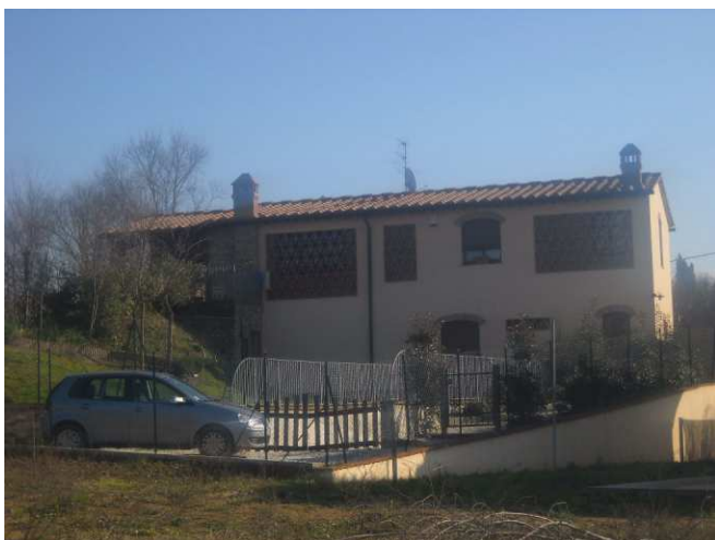
FOTO 7 - Rif. B - veduta del fienile lato Ovest
