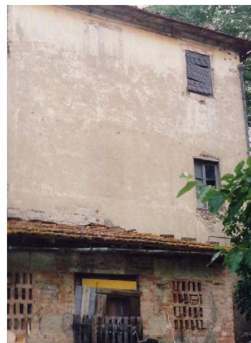
FOTO 5 - Rif. A - Il prospetto meridionale
