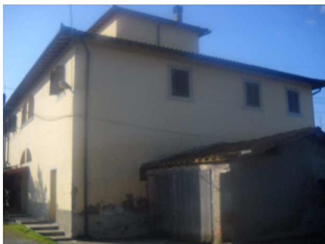
FOTO 4 - Rif. A - veduta lato Nord-Est, con annesso
