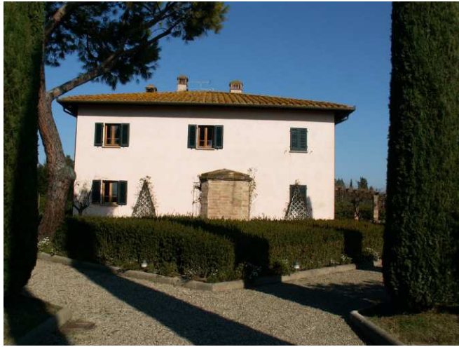
FOTO 1 - Rif. A - Prospetto principale
