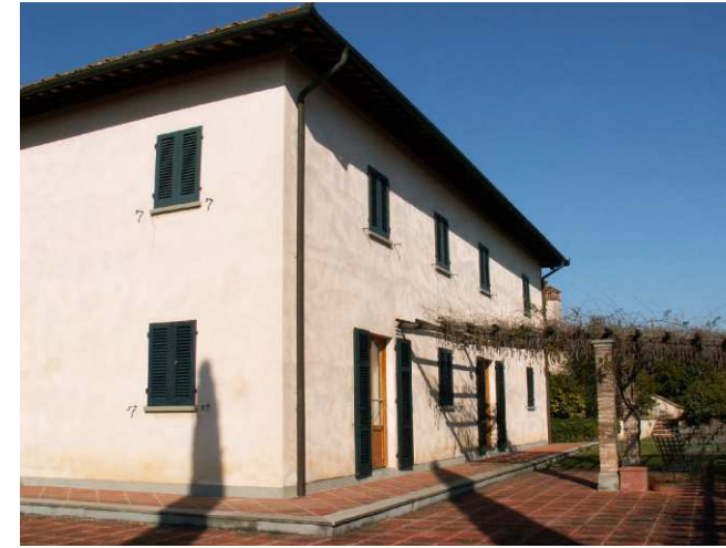
FOTO 3 - Rif. A - prospetto lato Est
