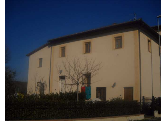
FOTO 3 - Rif. A - veduta lato Sud-Ovest
