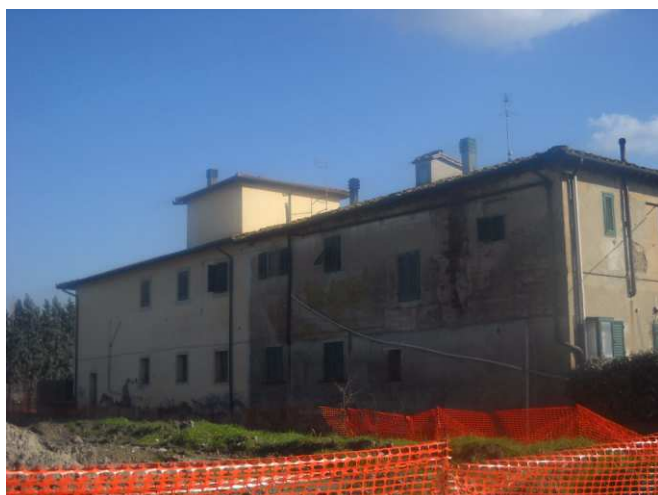
FOTO 1 - Veduta del fronte Nord, sulla strada
