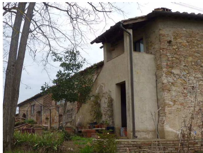
FOTO 7 - Rif. A - una scala ristrutturata di recente
