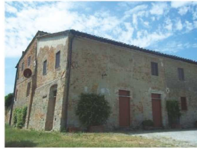
FOTO 2 - Prospetto laterale - edificio A
