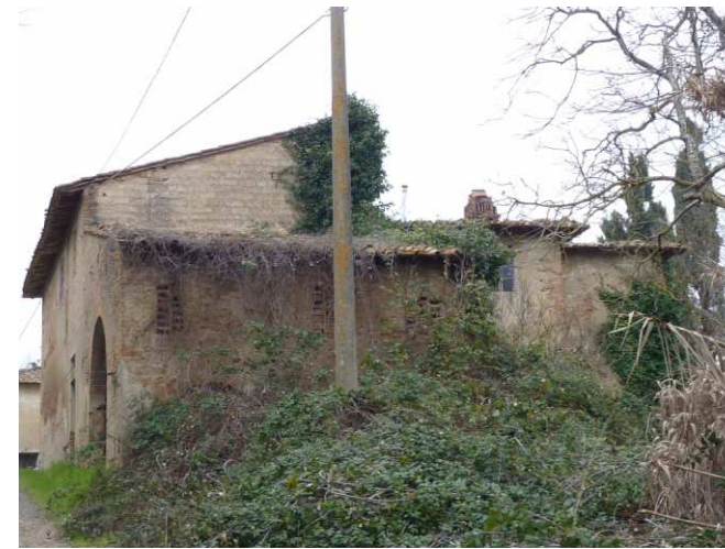
FOTO 3 - uno dei prospetti sul retro nascosto dalla vegetazione
