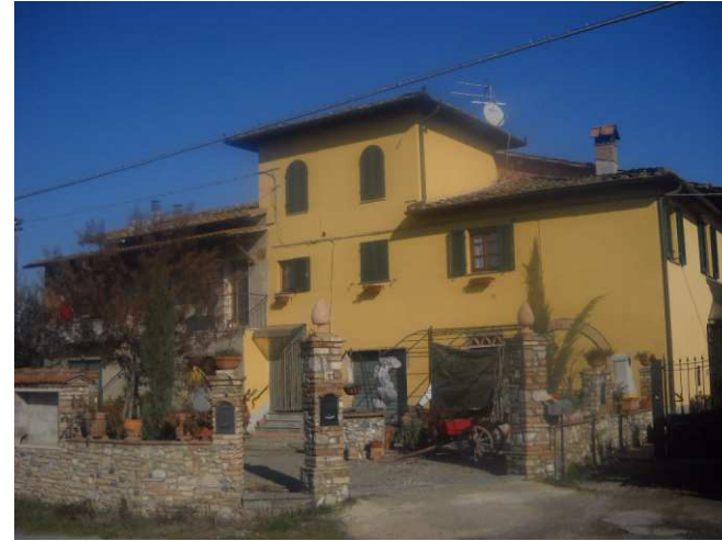
FOTO 2 - Rif. A - prospetto frontale
