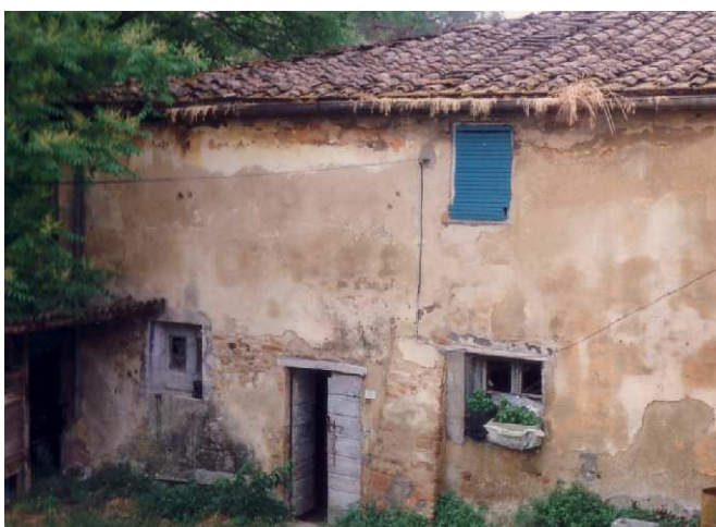
FOTO 4 - Rif. A - Un tratto del prospetto settentrionale
