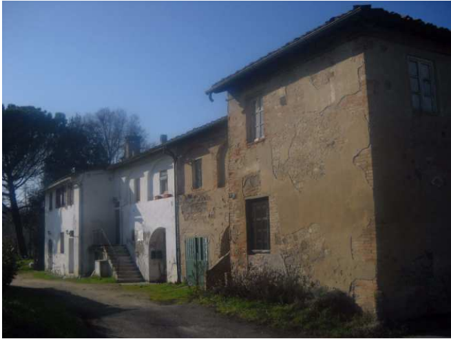
FOTO 1 - Rif. A - prospetto frontale
