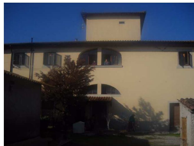
FOTO 5 - Rif. A - fronte principale della casa colonica
