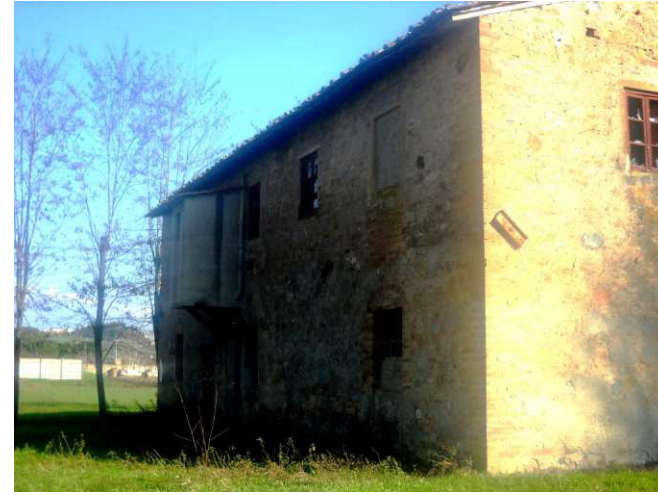
FOTO 2 - Rif. A - veduta da nord
