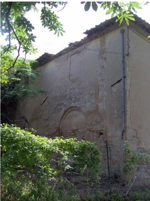
FOTO 4 - Rif. A - Un angolo dell'edificio
