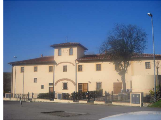
FOTO 2 - Rif. A - veduta del fronte principale su strada
