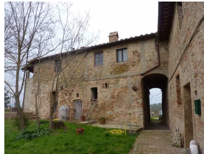
FOTO 6 - Rif. A - vista del passaggio interno
