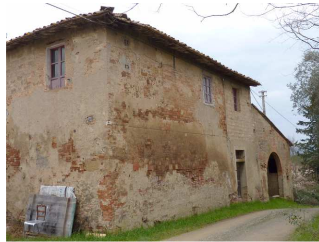
FOTO 2 - prospetto lato dx sulla strada
