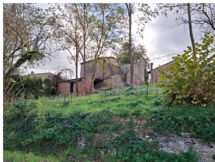
Edificio C - Prospetto sinistro/retro
