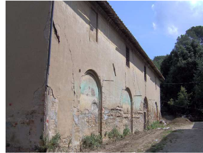
FOTO 3 - Rif. A - Vista del lato settentrionale
