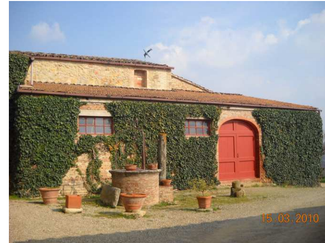
FOTO 3 - Rif. A - veduta dell'ala principale del prospetto
