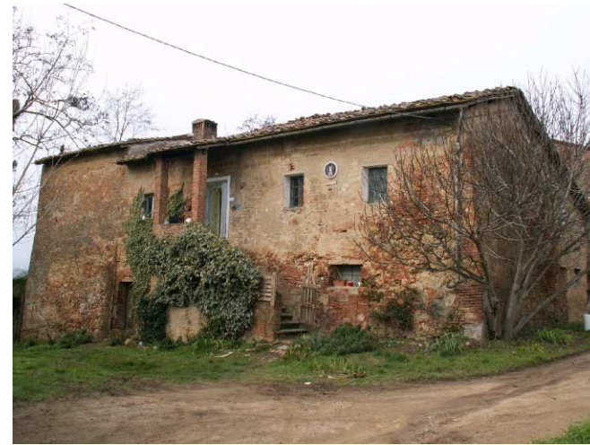
FOTO 2 - Rif. A' - prospetto lato dx
