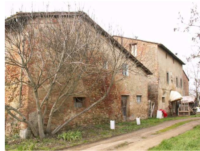
FOTO 3 - Rif. A - Fronte principale
