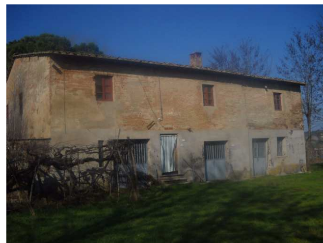
FOTO 5 - Rif. B - fronte principale della casa colonica
