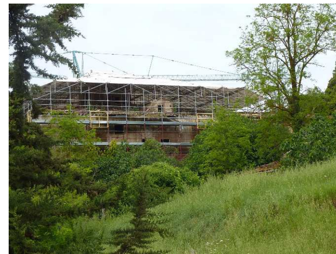
FOTO 15 - Rif. A - Il lato meridionale impalcato
