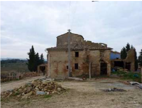
FOTO 1 - Rif. A Prospetto laterale sinistro
