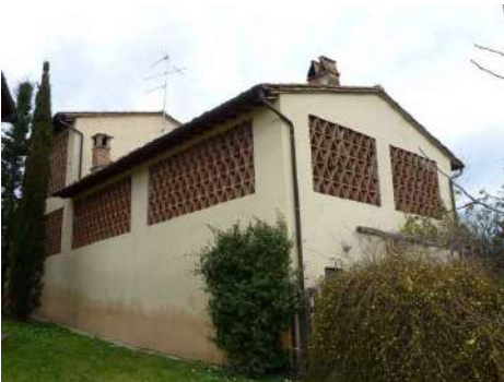
FOTO 14- Rif. C - veduta del retro e e lato sx
