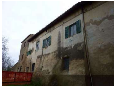
FOTO 8 - Rif. A - prospetto laterale della colonica
