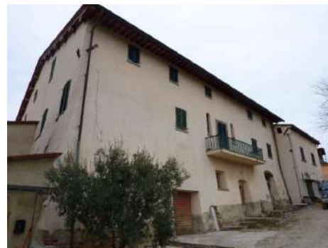
FOTO 3 - Rif. A - veduta del lato sud-est
