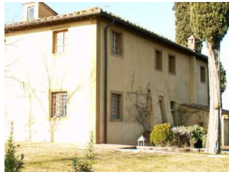
FOTO 5 - Rif. A - prospetto laterale Est
