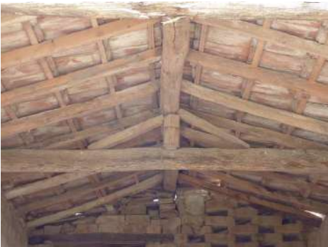
FOTO 14 - Rif. B - particolare della copertura dall'interno
