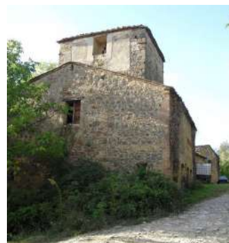
FOTO 3 - Vista tergale - edificio A
