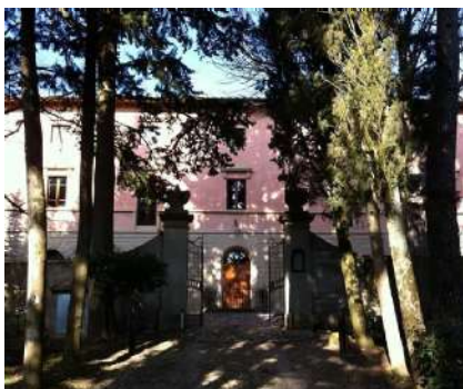
FOTO 4 - veduta del fronte
