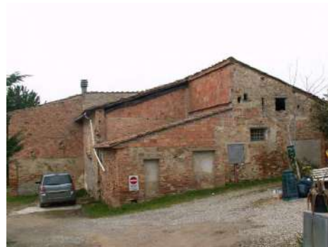
FOTO 4 - Rif. A - veduta lato retrostante al lato principale
