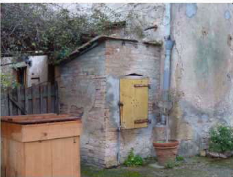
FOTO 7 - Rif. A - particolare del pozzo
