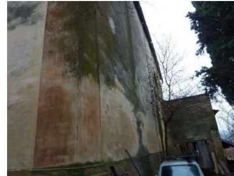
FOTO 6 - Rif. A' - lato esterno della chiesa
