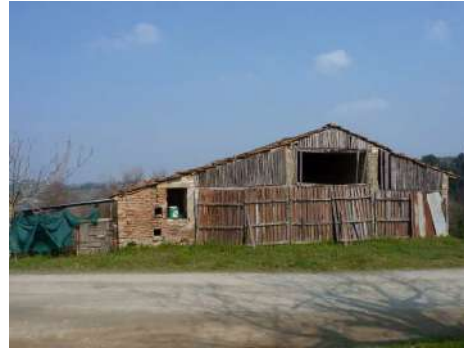
FOTO 11- Rif. B - il fronte verso strada del fienile
