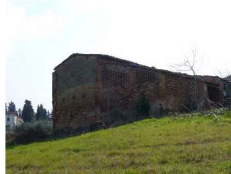
FOTO 12- Rif. B - il fronte verso strada del fienile
