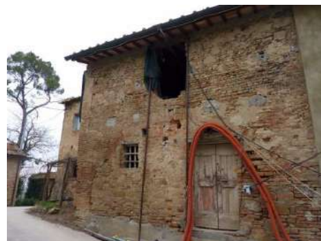
FOTO 5 - Rif. B - veduta del lato a sud-ovest
