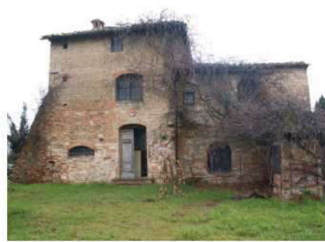
FOTO 2 - Rif. A - prospetto frontale
