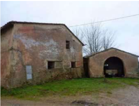
FOTO 4 - Rif. A-B - aggregazione dei corpi principali
