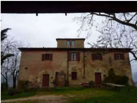
FOTO 1 - Veduta del fronte principale
