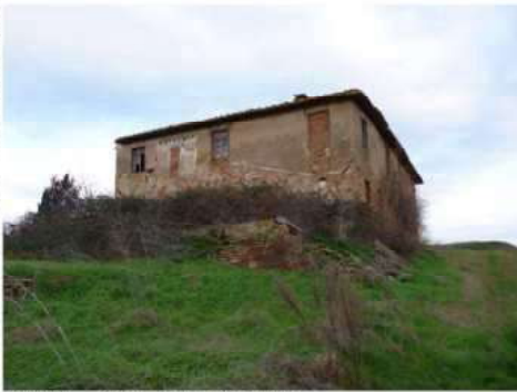
FOTO 1 - Rif. A - Prospetto Ovest
