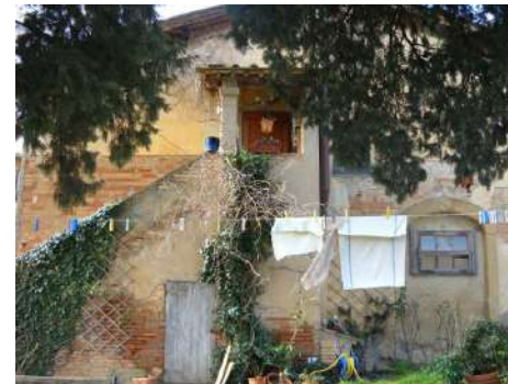
FOTO 6 - Rif. A - particolare della scala in muratura
