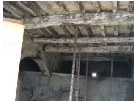
FOTO 5 - Rif. A - particolare del solaio al piano terreno
