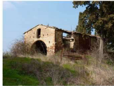
FOTO 5 - Rif. B - veduta da sud-est
