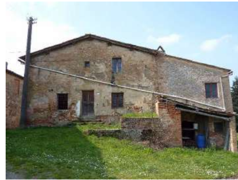
FOTO 2 - Rif. A - il prospetto timpanato verso strada
