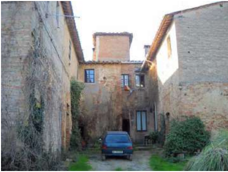
FOTO 1 - Rif. A - prospetto lato interno
