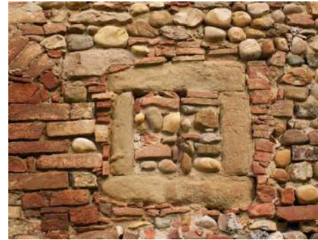
FOTO 6 - Rif. A - un particolare della bella muratura con ciottolame, laterizio e pietra della parete est
