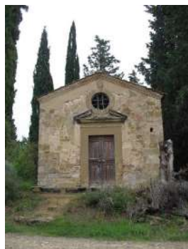
FOTO 2 - Vista della facciata
