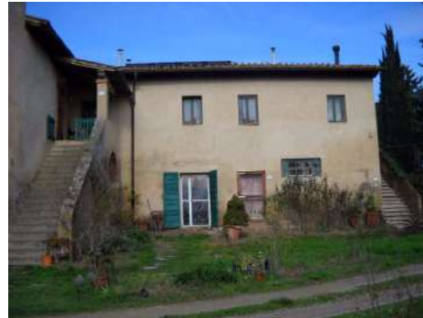
FOTO 2 - Rif. A - uno dei prospetti principali
