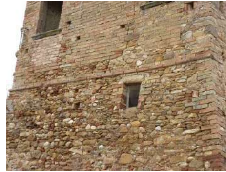
FOTO 3 - Rif. A - Part. della cornice marcapiano
