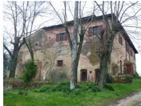
FOTO 2 - Rif. A - prospetto lato Ovest
