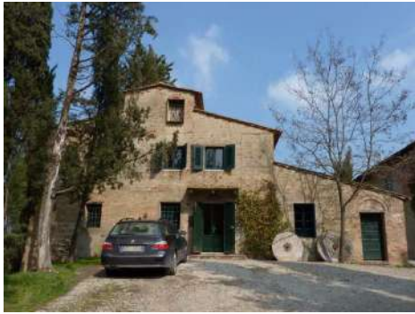
FOTO 1 - Rif. A - Veduta del fronte principale a sud-est
