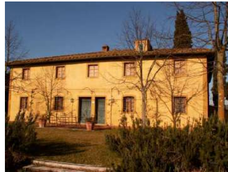
FOTO 2 - Rif. A - prospetto principale
