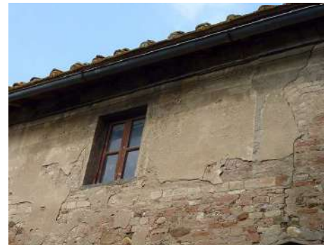
FOTO 9 - Rif. A - particolare di una finestra e della gronda del lato lungo
