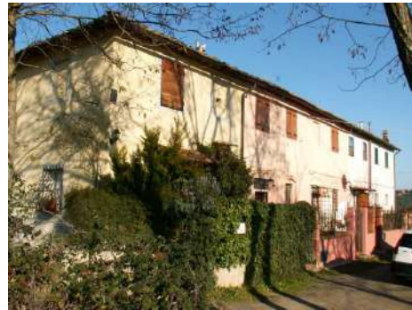
FOTO 2 - Rif. A - prospetto principale a valle da Ovest
