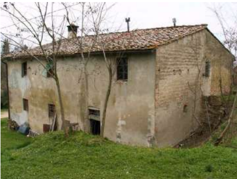
FOTO 4 - Rif. A - veduta del retro e del lato sx
