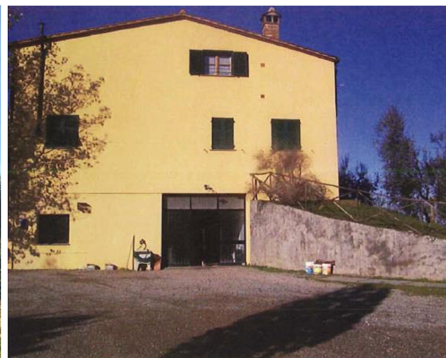
Edificio A – Foto2, Prospetto destro (Fonte pratica edilizia 12/2013)
