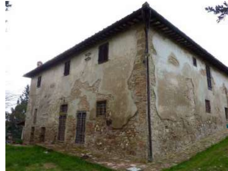
FOTO 2 - Rif. A - prospetto principale e lato sx
