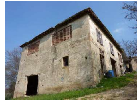
FOTO 13 - Rif. C - veduta lato ovest
