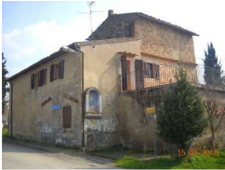
FOTO 4 - Rif. A-B - veduta d'insieme da Ovest del lato e del retro
