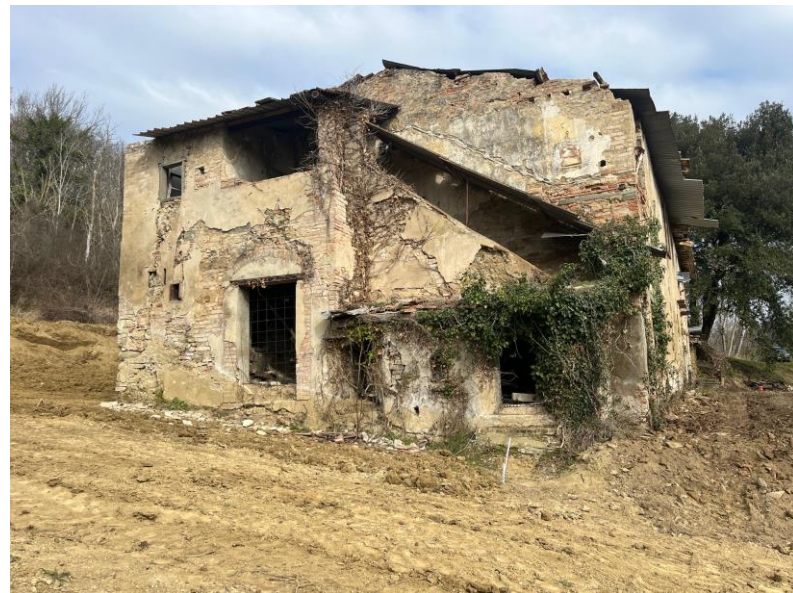
FOTO 3 – Rif. A - Prospetto sinistro
