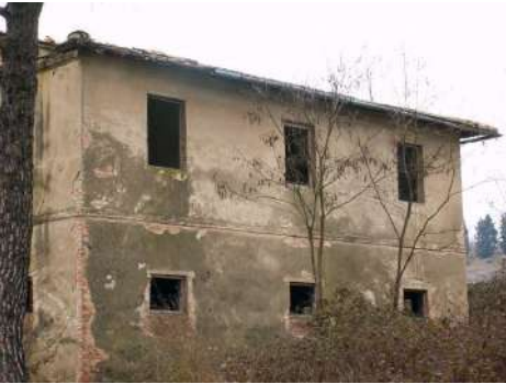
FOTO 4 - Rif. A - veduta del lato Sud
