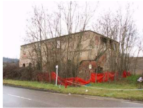
FOTO 2 - Rif. A - prospetto principale e lato sx
