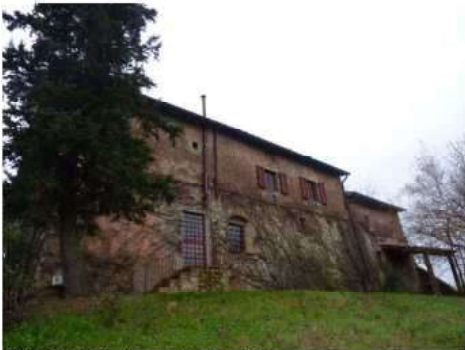
FOTO 4 - Rif. A - veduta lato Est
