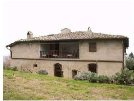
FOTO 2 - Rif. A - Prospetto laterale con loggia
