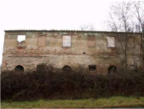
FOTO 1 - Rif. A - prospetto principale
