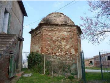
FOTO 4 - Rif. A - veduta del retro dell'edificio
