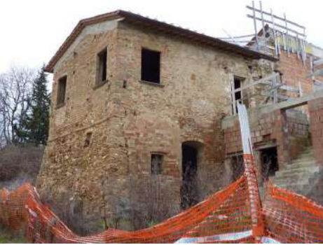
FOTO 4 - Rif. A - Veduta del lato sx
