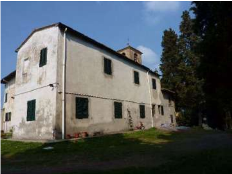
FOTO 4 - Rif. A - veduta del retro dell'edificio
