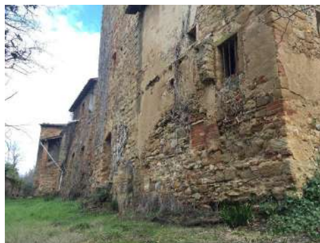
FOTO 5 - Particolare del paramento murario - edificio A
