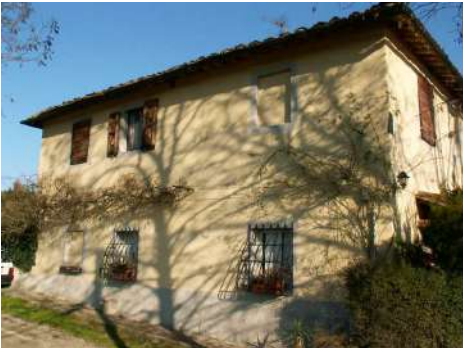
FOTO 4 - Rif. A - veduta del lato Est
