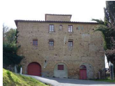
FOTO 2 - Rif. A - prospetto principale
