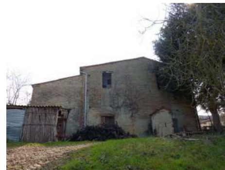
FOTO 9 - Rif. B - veduta del lato a nord
