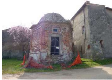
FOTO 2 - Rif. A - il prospetto principale su strada
