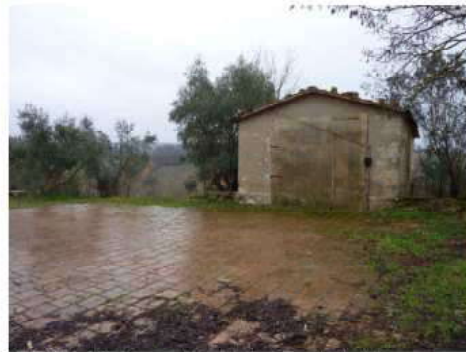
FOTO 5 - Rif. D - veduta del fronte principale
