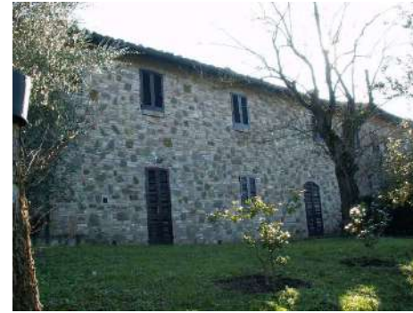
FOTO 3 - Rif. A - prospetto laterale sulla strada
