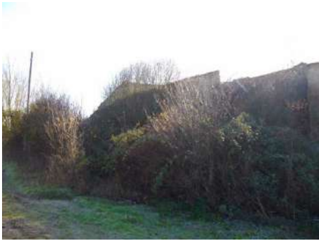
FOTO 1 - Veduta dalla strada
