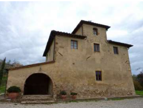
FOTO 4 - Rif. A - prospetto del fronte principale
