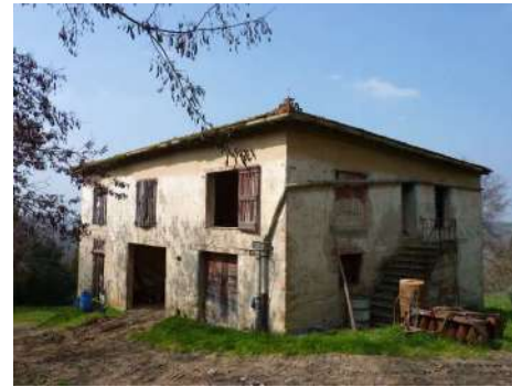
FOTO 12 - Rif. C - veduta del fronte e lato est
