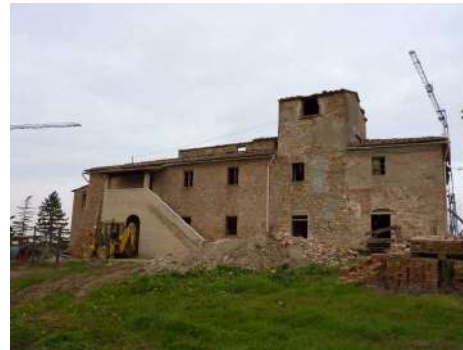
FOTO 2 - Rif. A - prospetto principale con la torre colombaria e la scala esterna
