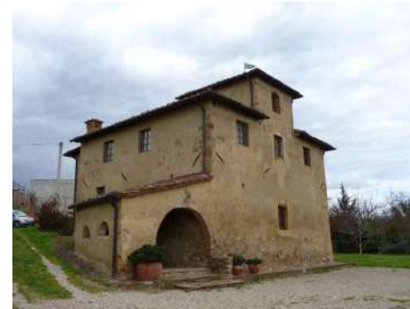
FOTO 3 - Rif. A - fronte principale e lato dx
