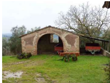
FOTO 8 - Rif. C - veduta frontale dell'annesso con aia
