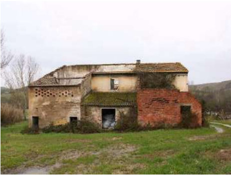
FOTO 4 - Rif. A' - prospetto retro
