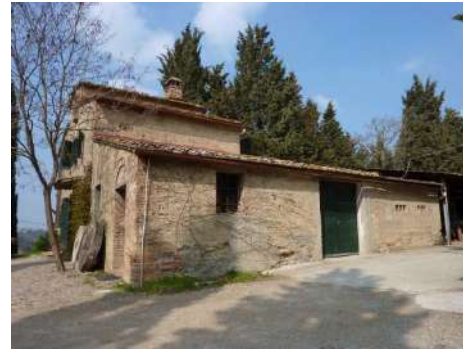
FOTO 2 - Rif. A - veduta del lato a sud-est e annesso giustapposto
