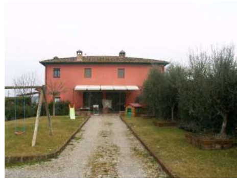
FOTO 2 - Rif. A - prospetto principale
