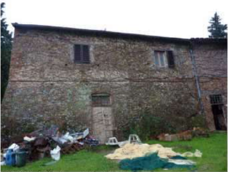
FOTO 4 - Rif. A - veduta del lato sx
