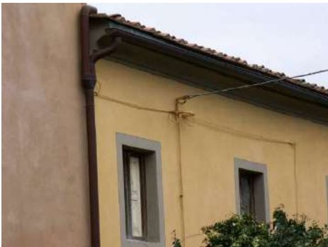
FOTO 4 - particolare della gronda della canonica
