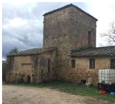
FOTO 2 - Vista laterale - edificio A
