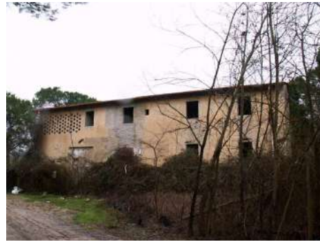
FOTO 2 - Rif. A - prospetto retro
