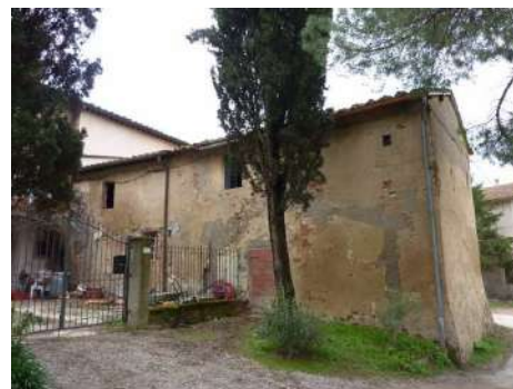
FOTO 6 - Rif. B - veduta del lato a nord-est
