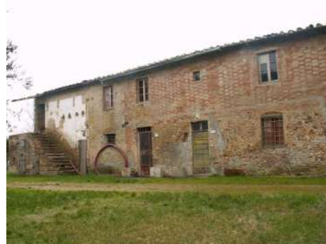
FOTO 2 - Rif. A - prospetto principale con scala di ingresso
