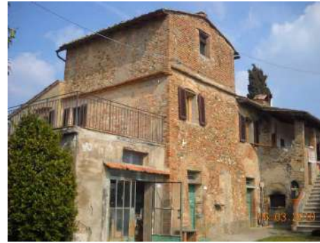
FOTO 2 - Rif. A - prospetto Ovest: in primo piano il volume del garage che altera le forme originarie (rif. B)
