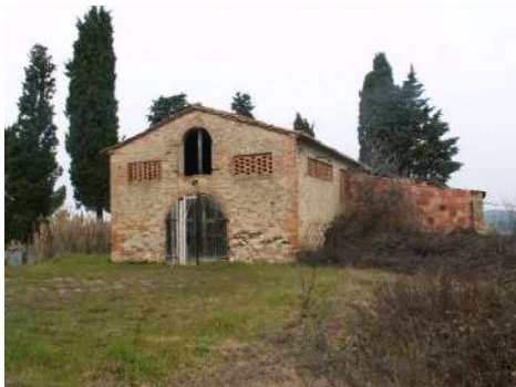
FOTO 7 - Rif. B - prospetto principale del fienile
