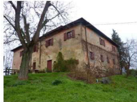
FOTO 5 - Rif. A - veduta generale da Sud
