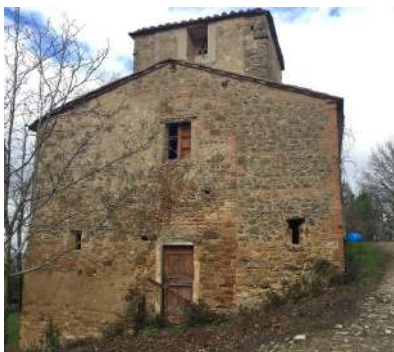
FOTO 4 - Prospetto del retro - edificio A
