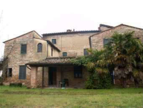
FOTO 4 - Rif. A - veduta prospetto laterale
