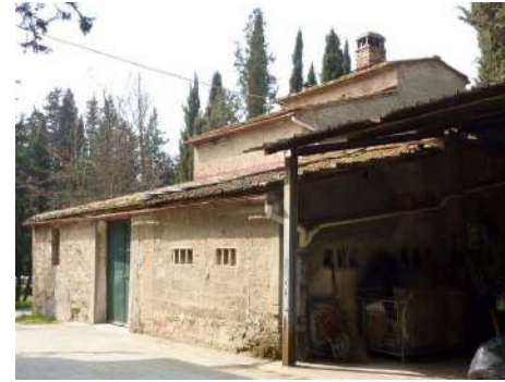
FOTO 3 - Rif. A - veduta del retro a nord-est
