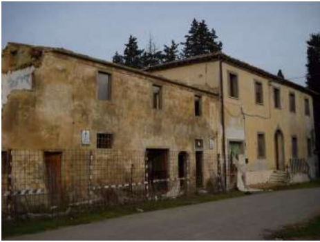
FOTO 1- Rif. A e A' - prospetto principale lungo strada
