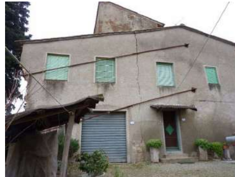
FOTO 2 - Rif. A - veduta della testata nord e torretta
