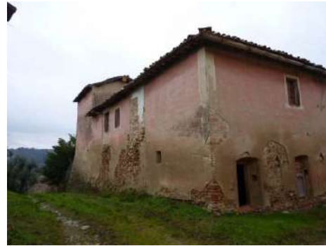
FOTO 5 - Rif. A - veduta lato Nord
