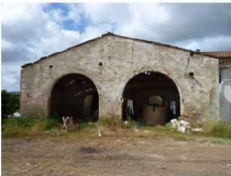
FOTO 4 - Rif. B - veduta del fronte principale
