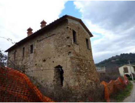
FOTO 1 - Rif.A- Veduta lato dx della testata
