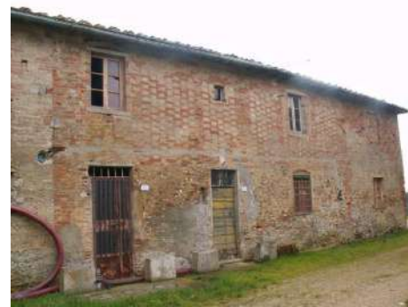
FOTO 3 - Rif. A - prospetto principale
