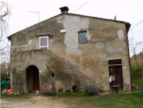
FOTO 1 - Rif. A - prospetto frontale
