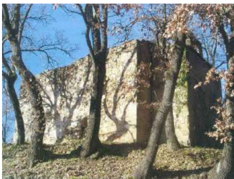
FOTO 4 - veduta laterale e retro
