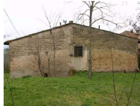
FOTO 3 - Rif. A - prospetto retro
