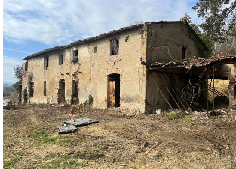
FOTO 1 – Rif. A - Prospetto frontale
