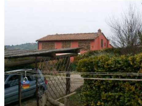
FOTO 6 - Rif. B - uno dei lati del fienile con parata ristrutturato
