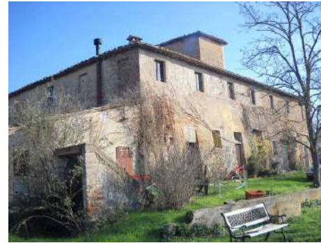
FOTO 6 - Rif. A - prospetto principale e lato sx
