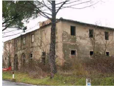
FOTO 5 - Rif. A - veduta generale da Sud
