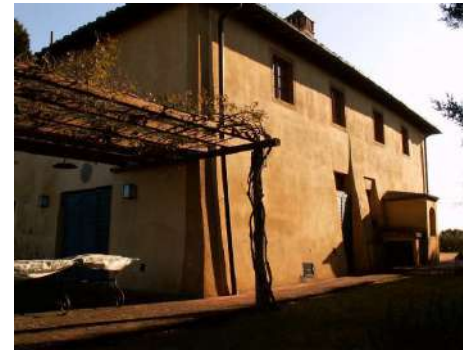
FOTO 3 - Rif. A - prospetto laterale Ovest
