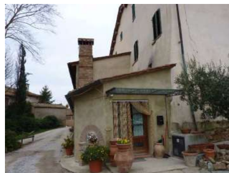
FOTO 9 - Rif. B' - veduta del lato a sud-est (ingresso)
