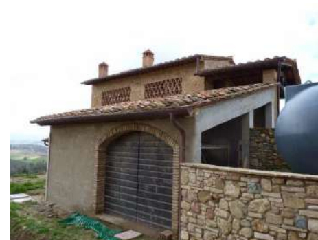
FOTO 9 - Rif. B - veduta parziale del lato dx
