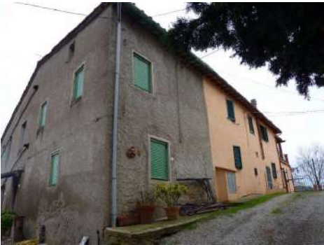
FOTO 1 - Rif. A - fronte principale a nord-ovest
