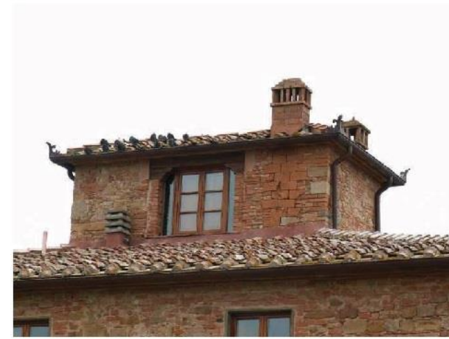
FOTO 3 – Rif. A – particolare del torrino colombaia
