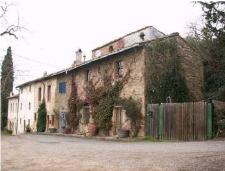
FOTO 1 - Rif. A - prospetto frontale - parte
