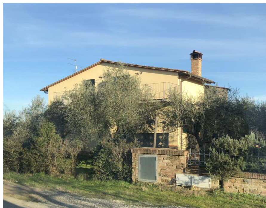
Edificio A – Foto1, Prospetto sinistro (gennaio 2024)
