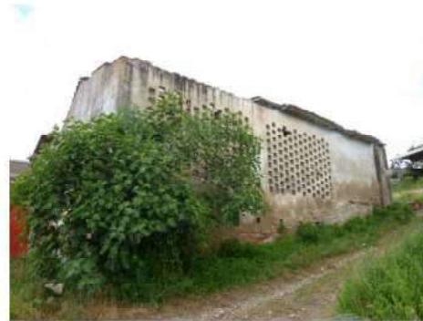
FOTO 5 - Rif. B - veduta del laterale posta ad Ovest
