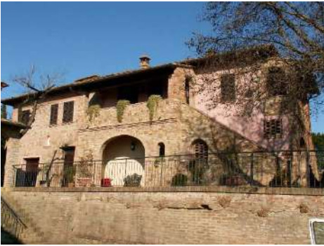
FOTO 1 - Rif. A - prospetto frontale
