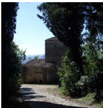
FOTO 1 - Vista della casa colonica a torre
