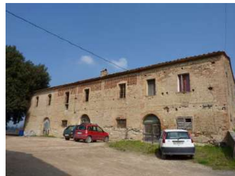
FOTO 8 - Rif. B - veduta del fronte principale sull'aia
