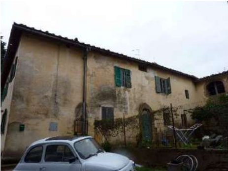
FOTO 4 - Rif. A - prospetto interno
