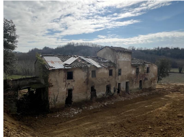
FOTO 2 – Rif. A - Prospetto retro
