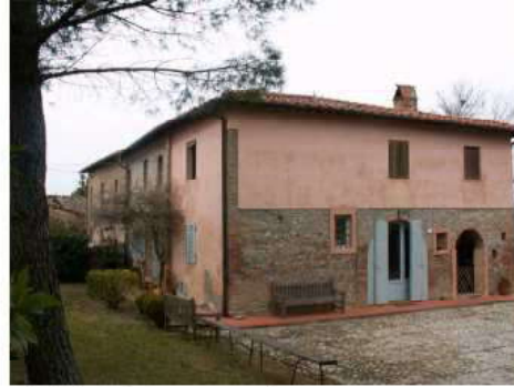
FOTO 2 - Rif. A - prospetto lato est
