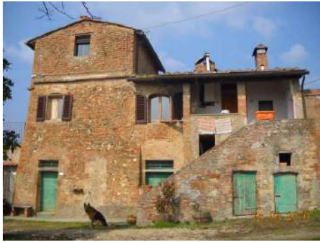
FOTO 1 - Rif. A prospetto principale con la torretta in evidenza
