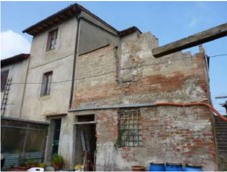
FOTO 4 - Rif. A - veduta del retro dell'edificio
