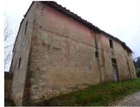
FOTO 3 - Rif. A - veduta del prospetto su strada
