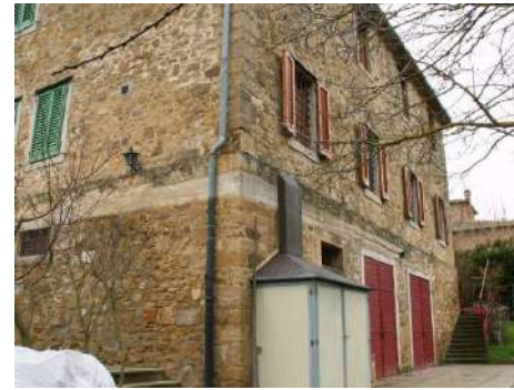
FOTO N°3 - Rif. A - veduta del retro
