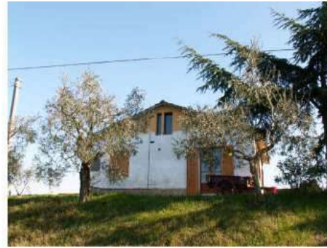
FOTO 2 - Rif. A - prospetto frontale
