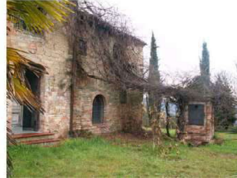
FOTO 6 - Rif. A - particolare del fronte con pozzo
