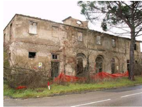
FOTO 2 - Rif. A - prospetto frontale su strada
