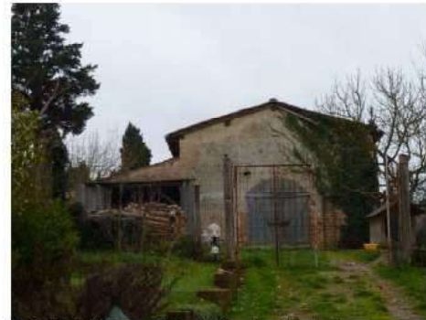
FOTO 5- Rif. B - veduta del fronte principale
