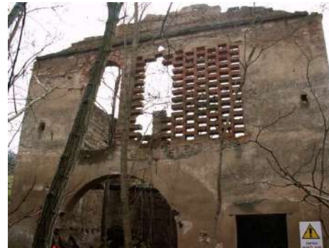
FOTO 5 - Rif. B - Fienile testata principale
