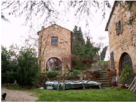
FOTO 4 - Rif. B - Prospetto laterale a valle
