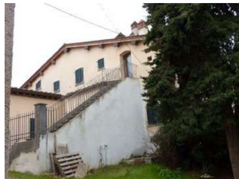
FOTO 2 - Rif. A - veduta del lato nord-est
