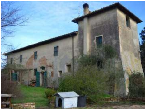
FOTO 4 - Rif. A - prospetto dal lato della torre
