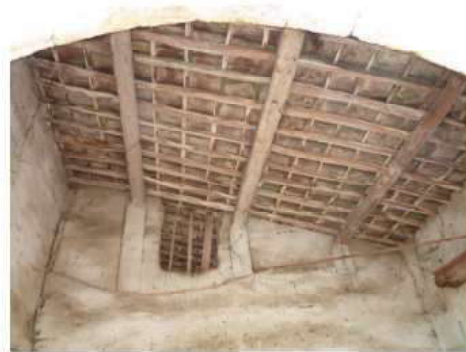
FOTO 5 - Rif. B - veduta della copertura dall' interno
