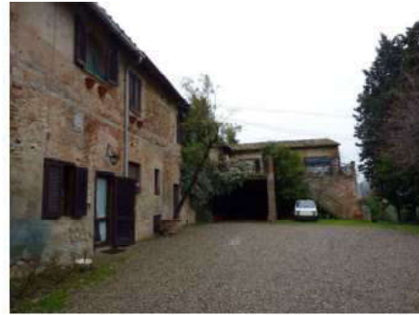
FOTO 2 - Rif. A - veduta parziale del fronte principale
