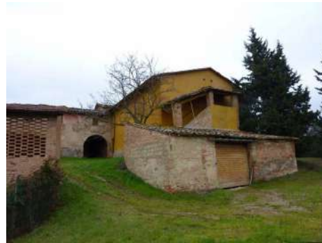
FOTO 2 - Rif. A - veduta lato Sud
