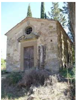
FOTO 1 - Vista della facciata
