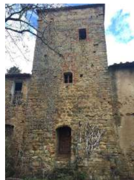
FOTO 6 - Torre - edificio A
