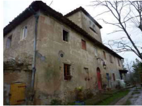
FOTO 2 - Rif. A - prospetto principale
