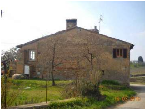
FOTO 7 - Rif. A - veduta del lato destro
