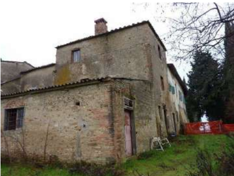
FOTO 7 - Rif. A- veduta della torre e dell'annesso
