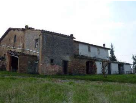
FOTO 4 - Rif. A' - veduta del retro dell'edificio, a sinistra il volumetto che ospita il forno
