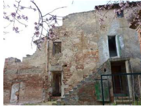
FOTO 2 - Rif. A - il prospetto di ingresso
