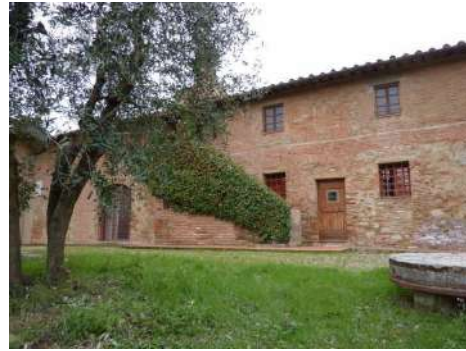
FOTO 2 - Rif. A - prospetto principale
