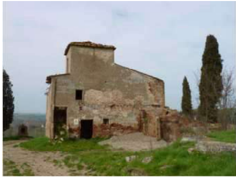
FOTO 1 - Rif. A - veduta del lato a est
