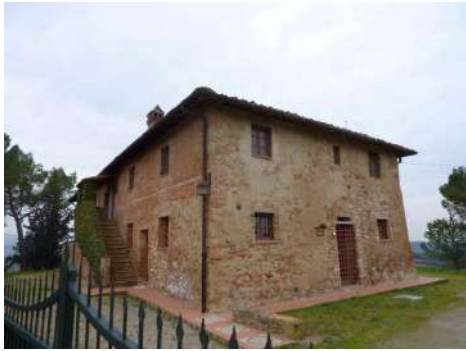
FOTO 1 - Rif. A - prospetto principale e lato sx
