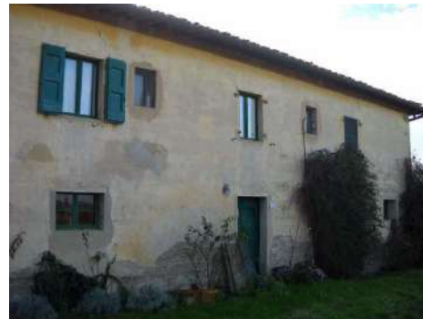
FOTO 5 - Rif. A - il prospetto sulla strada di accesso
