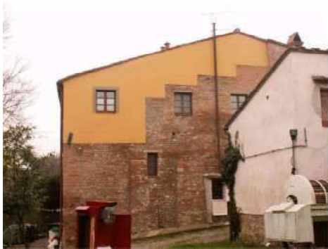
FOTO 4 - Rif. A - veduta lato ovest
