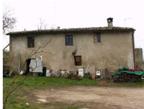
FOTO 2 - Rif. A - prospetto lato dx
