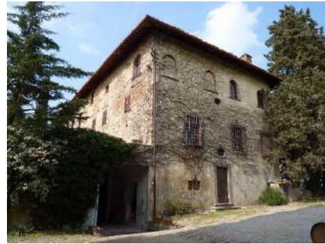
FOTO 5 - Rif. A - veduta del lato ad est
