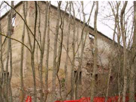
FOTO 4 - Rif. A - prospetto retro
