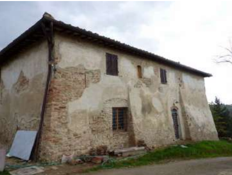
FOTO 4 - Rif. A - prospetto lato strada
