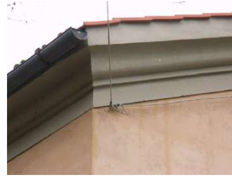
FOTO 3 - particolare della gronda della chiesa
