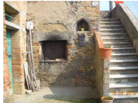
FOTO 8 - Rif. A - particolare della scala e del forno
