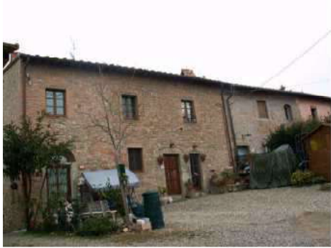
FOTO 1 - Rif. A - prospetto principale lungo strada
