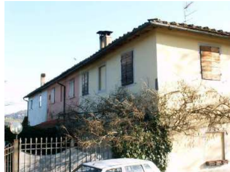
FOTO 5 - Rif. A - prospetto lato a monte
