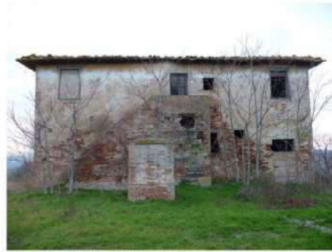
FOTO 2 - Rif. A - Prospetto Est
