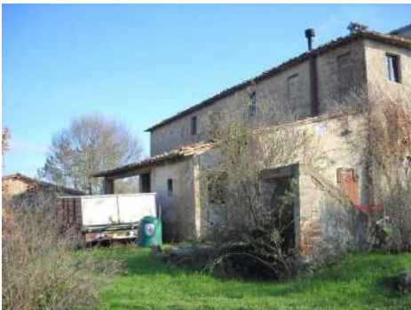
FOTO 7 - Rif. A - prospetto lato sx
