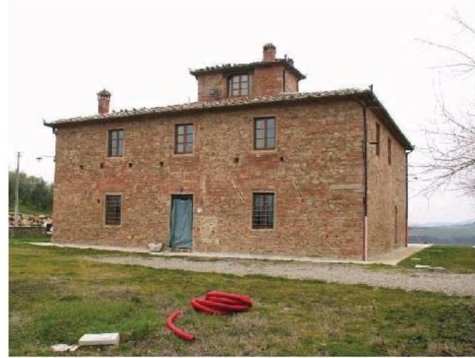
FOTO 1 – Rif. A – prospetto principale
