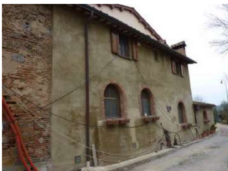
FOTO 7 - Rif. B' - veduta del lato a sud-ovest
