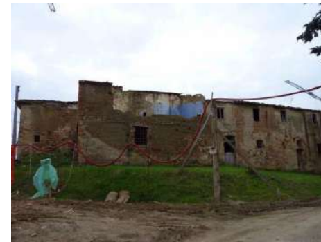
FOTO 6 - Rif. A-A' - lato retrostante il prospetto principale ripreso dalla strada di accesso
