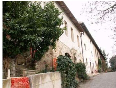
FOTO 2 - Rif. A - prospetto frontale - parte
