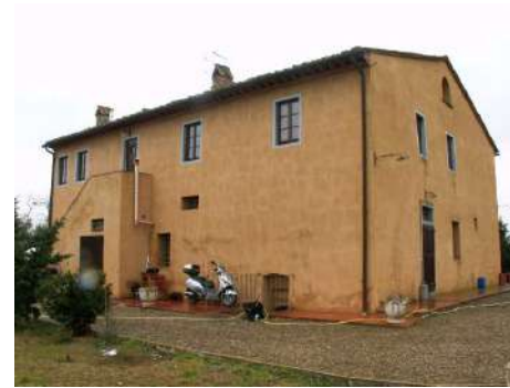
FOTO 3 - Rif. A - veduta del lato Est
