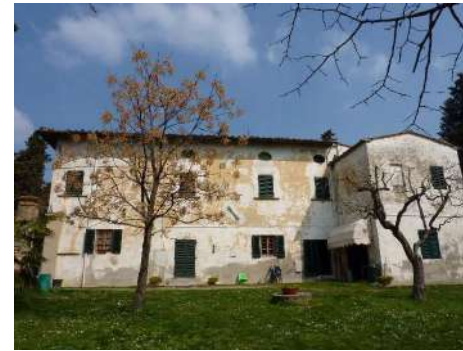
FOTO 3 - Rif. A - prospetto del lato destro
