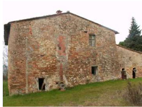
FOTO 2 - Rif. A - il prospetto settentrionale
