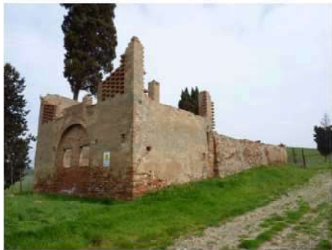
FOTO 7 - Rif. B- veduta lato a sud
