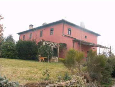
FOTO 1 - Rif. A - vista del lato sul retro e lato sx
