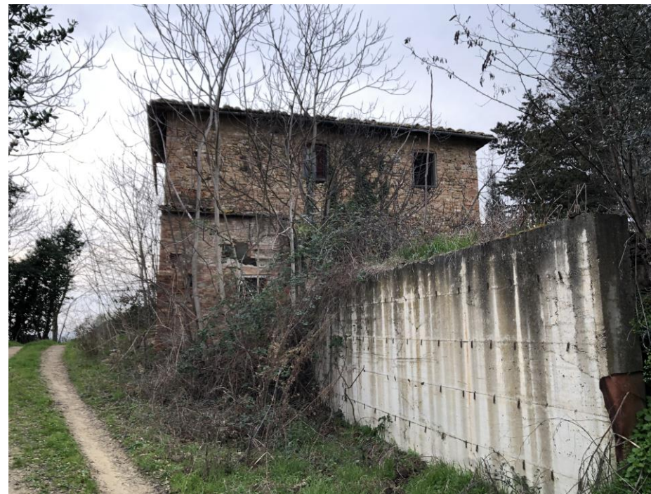
Foto 2 (edificio A – prospetto destro)
