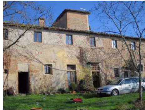
FOTO 5 - Rif. A - prospetto principale
