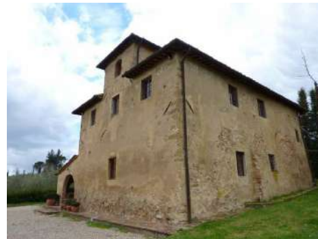
FOTO 5 - Rif. A - veduta del lato sx
