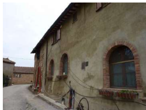
FOTO 8 - Rif. B' - veduta del lato a sud-ovest
