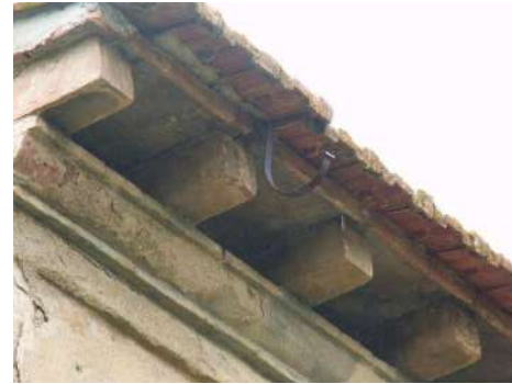
FOTO 5 - Rif. A - particolare della gronda
