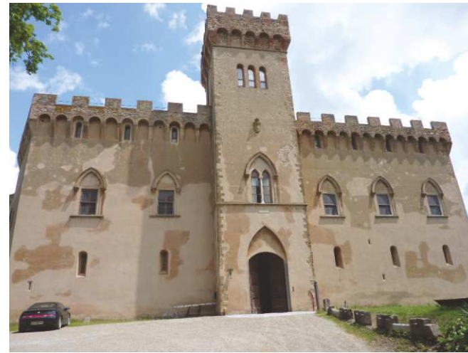
FOTO 2 - Rif. A - prospetto principale a Sud - Ovest
