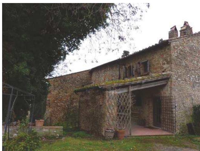
FOTO 1 - Rif. A - Parte dell'edificio nella zona nord-est
