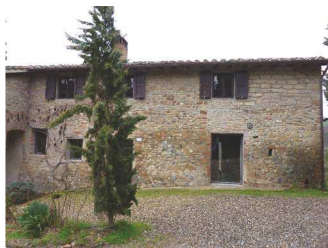
FOTO 2 - Rif. A - Il prospetto sud-ovest
