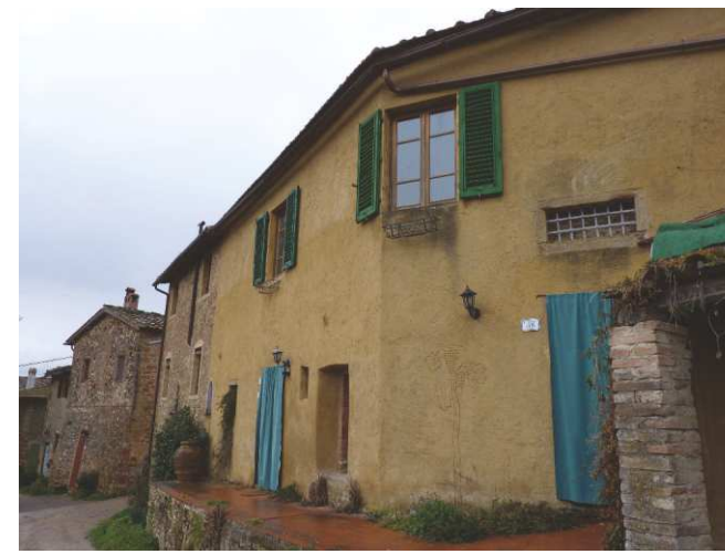
FOTO 3 - Rif. A - vista d'insieme dalla via principale
