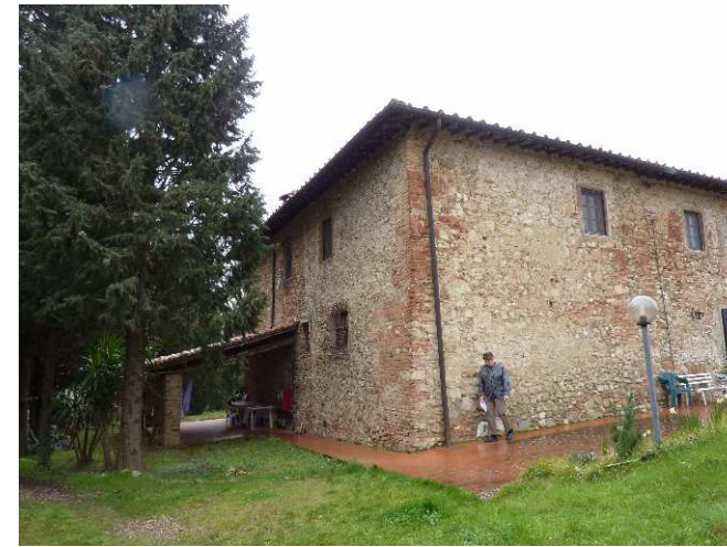
FOTO 3 - Rif. A - Prospetto laterale del lato orientale
