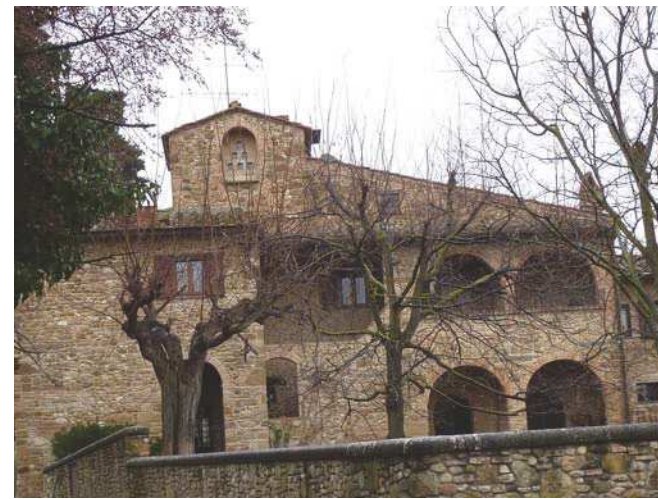
FOTO 2 - Rif. A - Particolare della facciata principale con la loggia profferlo ed il portico
