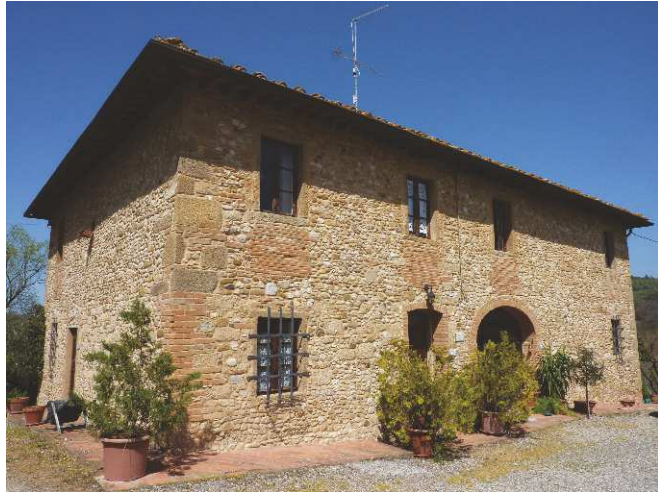
FOTO 1 - Rif. A - Il prospetto principale
