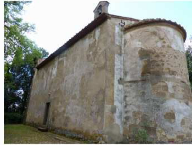
FOTO 11 - Rif. B - prospetto del retro e del lato sx
