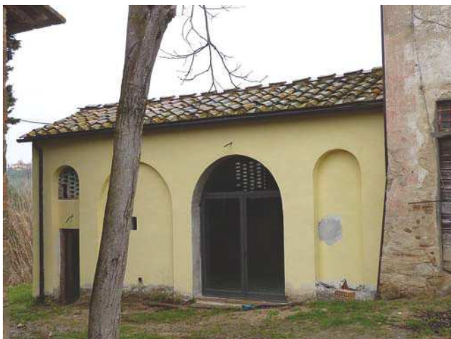
FOTO 7 - Rif. A - Il rustico della foto 6, recuperato di recente con una ristrutturazione, ripreso dal lato di ingresso
