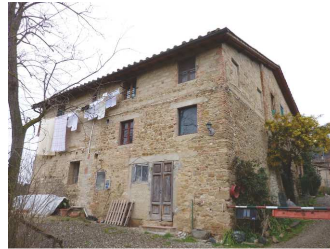
FOTO 5 - Rif. A - prospetto laterale a Sud
