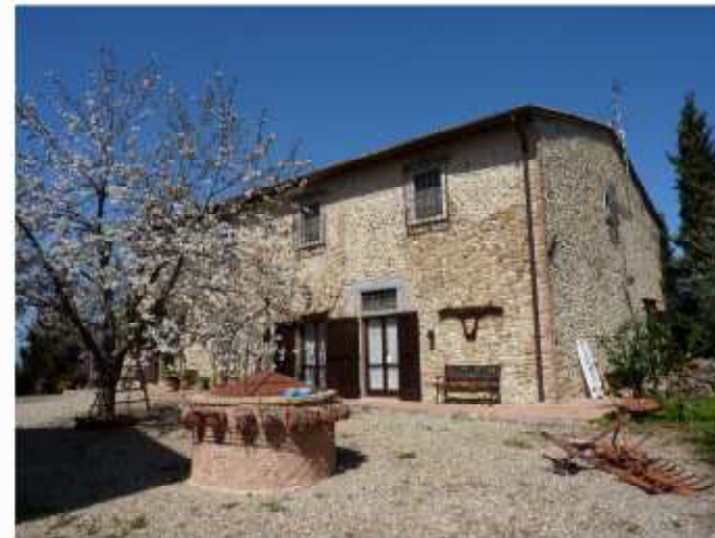
FOTO 5 - Rif. A - Il prospetto principale con il pozzo
