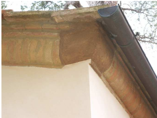
FOTO 4 - Rif. A - Particolare della gronda
