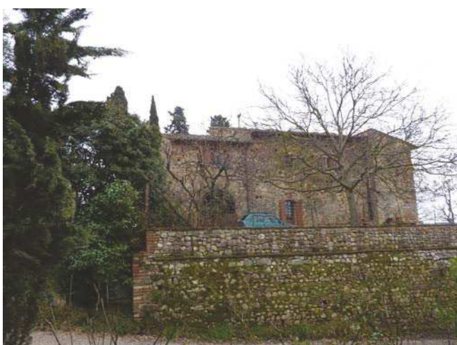
FOTO 1 - Rif. A - Il prospetto della colonica visto dalla strada
