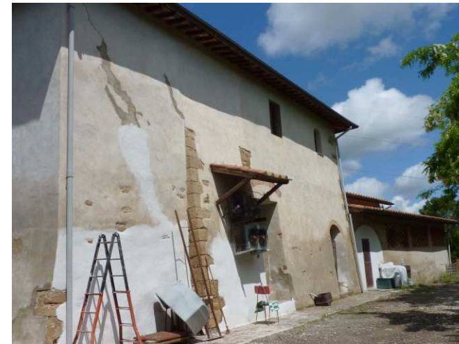
FOTO 6 - Rif. A - prospetto del retro a Est
