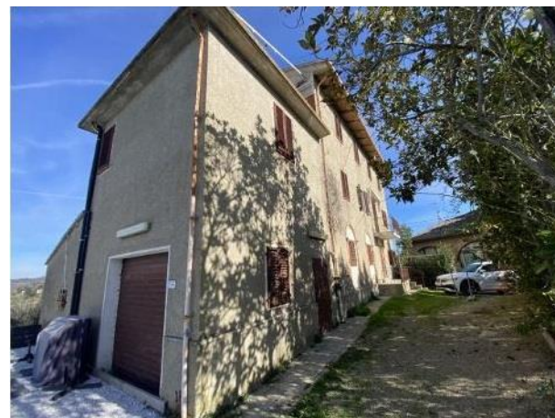
FOTO 2 – Prospetto sinistro/frontale frontale
