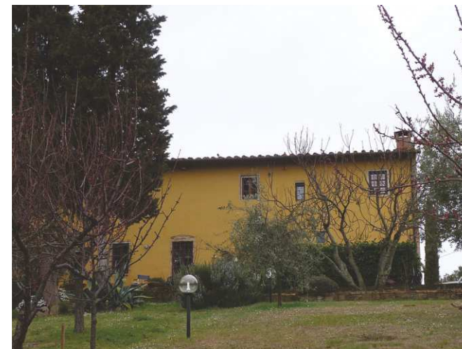
FOTO 6 - Rif. A - Particolare del prospetto sul retro
