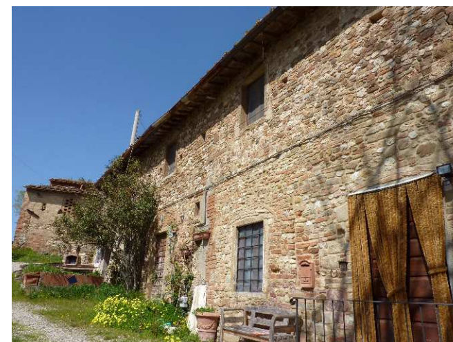
FOTO 3 - Rif. A - Il prospetto principale visto da sud
