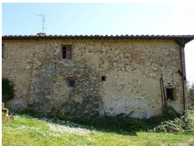
FOTO 4 - Rif. A - Parte del prospetto sul retro dell'edificio
