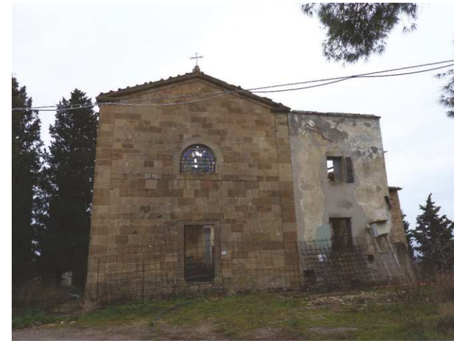
FOTO 3 - Rif. A - Chiesa prospetto principale
