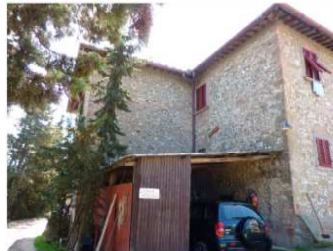
FOTO 5 - Rif. A - Vista di parte del prospetto nord, sul retro dell'edificio
