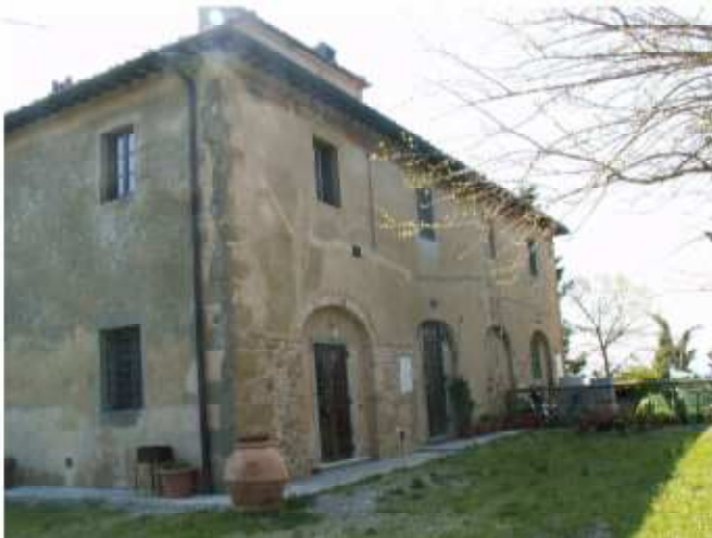
FOTO 4 - Rif. A - prospetto Ovest con loggia tamponata
