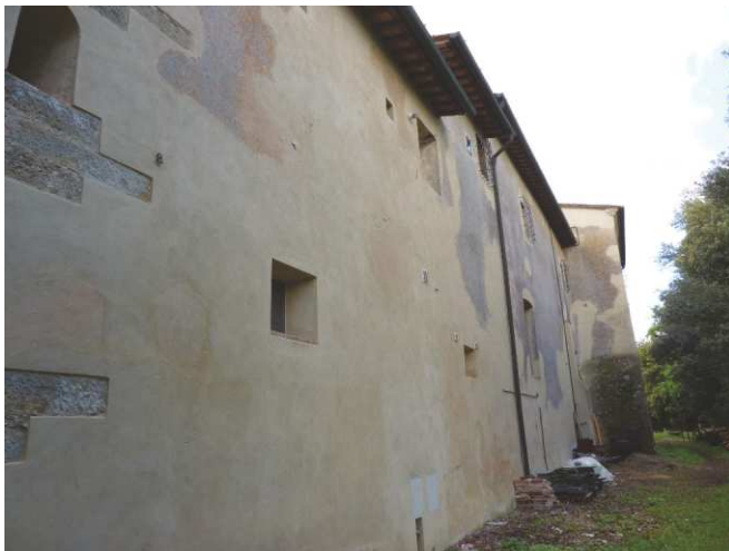
FOTO 4 - Rif. A - veduta del retro a Nord
