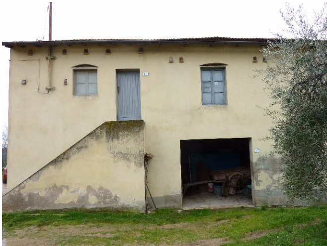
FOTO 4 - Rif. A - Il prospetto settentrionale
