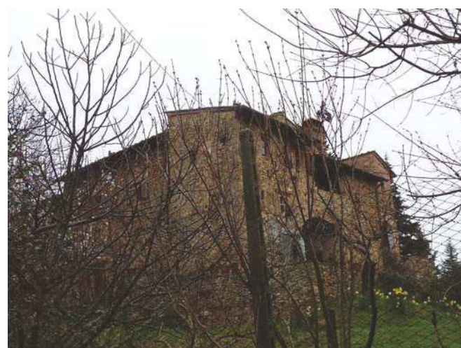
FOTO 2 - Rif. A - Il prospetto sud-ovest
