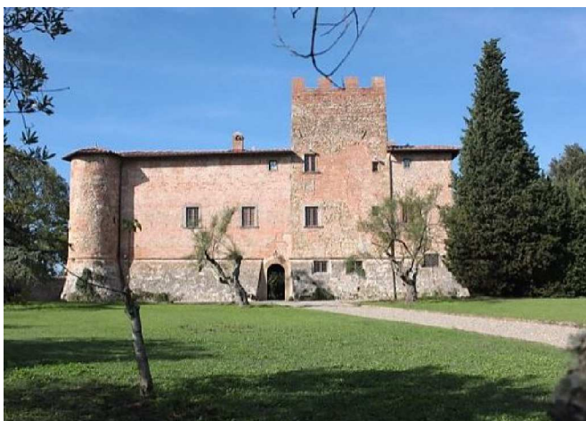
FOTO 1 - Rif. A - veduta del fronte del castello
