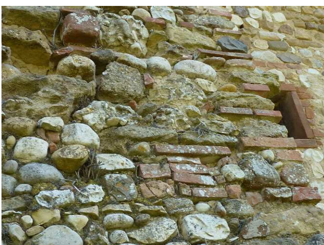
FOTO 7 - Rif. A - Particolare della muratura del prospetto di foto 6
