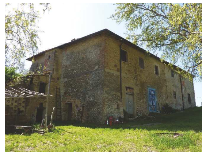
FOTO 3 - Rif. A - Il prospetto laterale nord ed il retro dell'edificio
