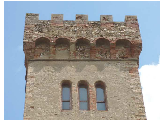
FOTO 6 - Rif. A - part. della torre sul fronte principale
