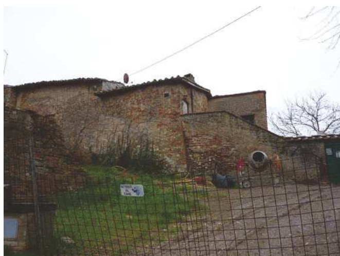
FOTO 4 - Rif. A - La facciata occidentale sul cortile
