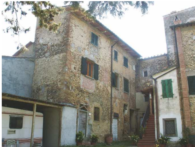
FOTO 4 - Rif. A - Il prospetto retrostante alla strada
