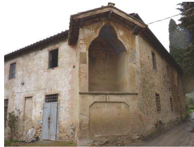
FOTO 2 - Rif. A - Il tabernacolo gotico presente sull'angolo nord dell'edificio
