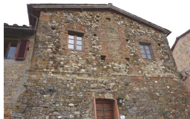
FOTO 2 - Rif. A - fronte principale ad Est
