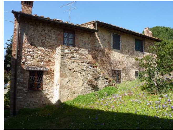
FOTO 2 - Rif. A - prospetto laterale a Sud - Est
