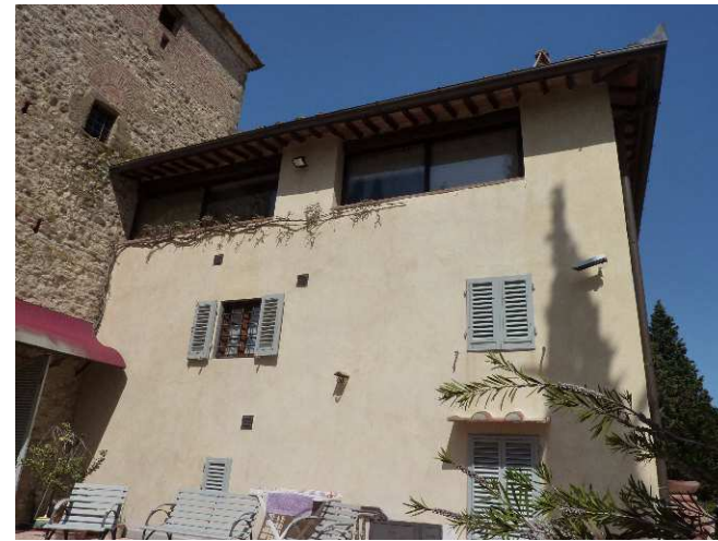
FOTO 2 - Rif. A - prospetto a Sud
