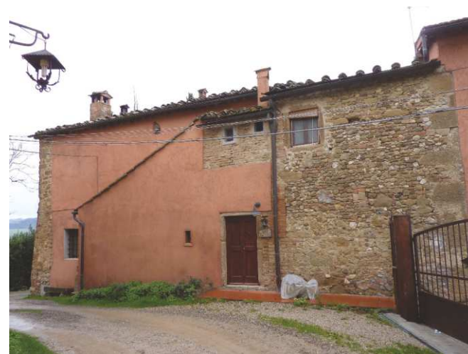
FOTO 5 - Rif. A - prospetto laterale a Nord
