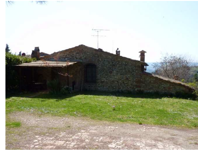
FOTO 3 - Rif. A - veduta del retro a Nord -Est
