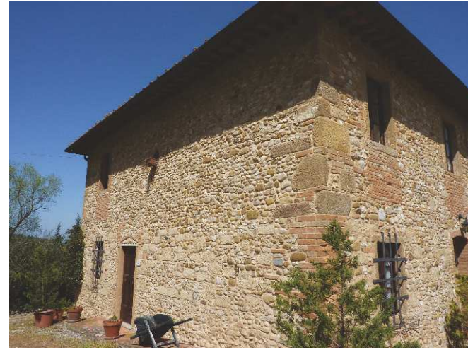
FOTO 2 - Rif. A - Il prospetto laterale ovest
