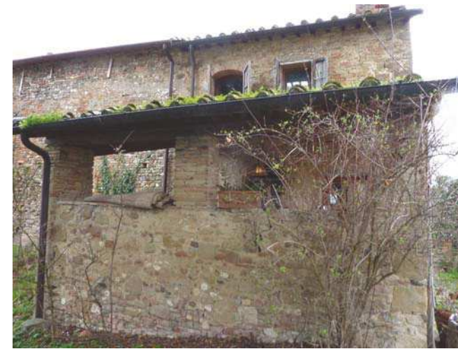
FOTO 3 - Rif. A - Particolare della facciata sud
