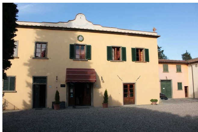
FOTO 4 - Rif. D - veduta del fronte della Fattoria
