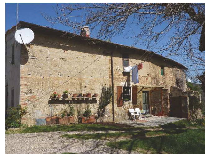
FOTO 6 - Rif. A - L'ingresso laterale che dà accesso ad uno degli appartamenti
