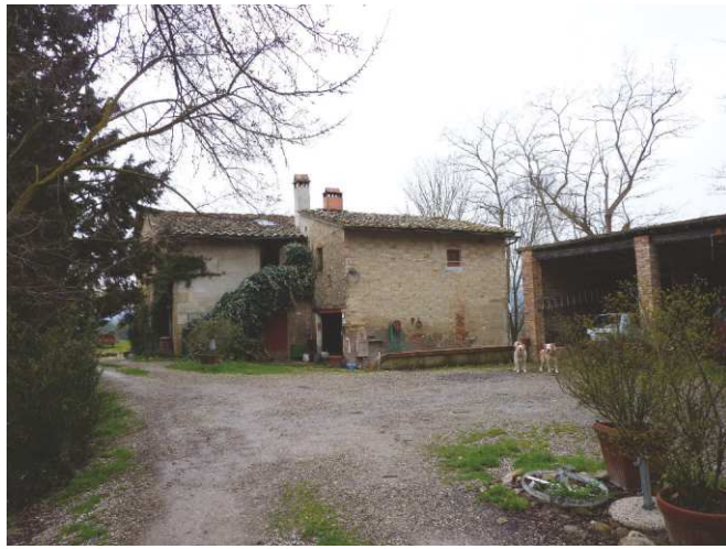
FOTO 1 - Rif. A - prospetto laterale Nord-Est
