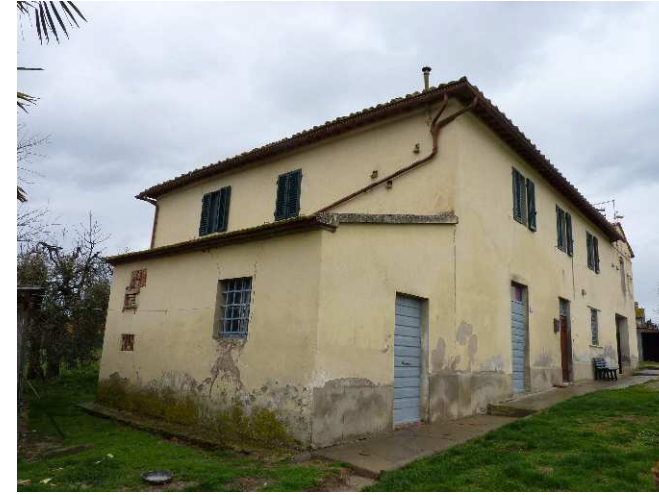
FOTO 3 - Rif. A - Il lato sud dell'edificio
