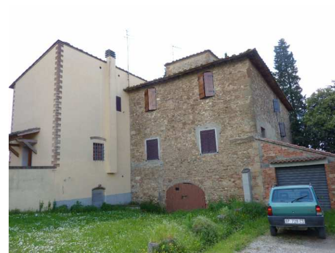
FOTO 3 - Rif. A - veduta del lato ad Est
