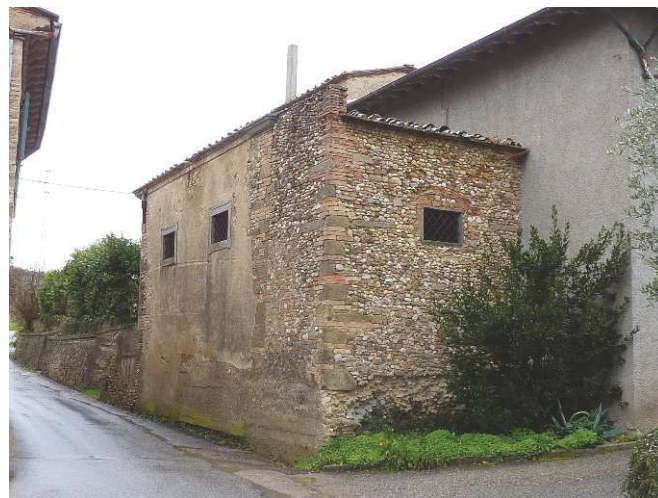
FOTO 4 - Rif. A - Il prospetto laterale ed il retro
