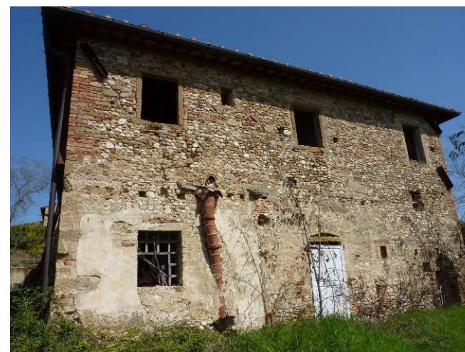
FOTO 6 - Rif. A - Il prospetto sud-ovest
