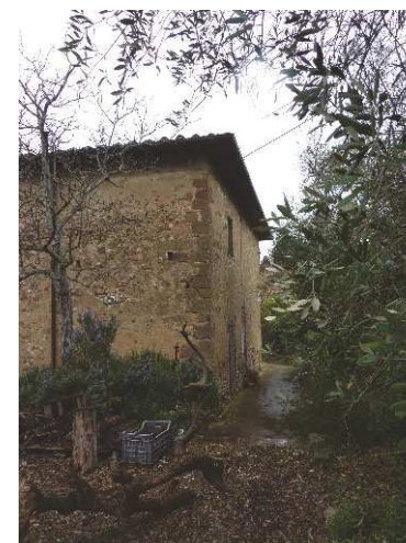
FOTO 6 - Rif. A - il lato verso la strada
