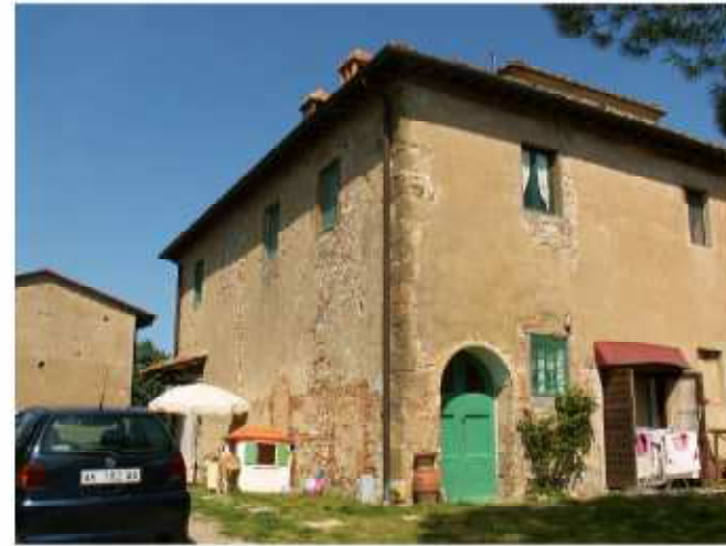
FOTO 2 - Rif. A - prospetto laterale Sud
