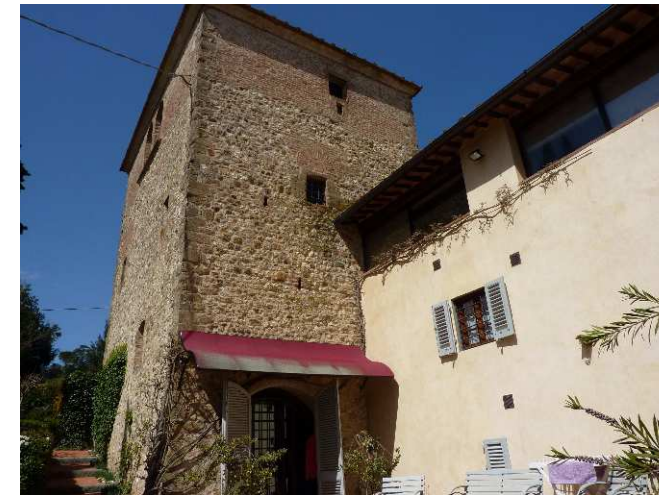
FOTO 3 - Rif. A - prospetto con Torre a Sud
