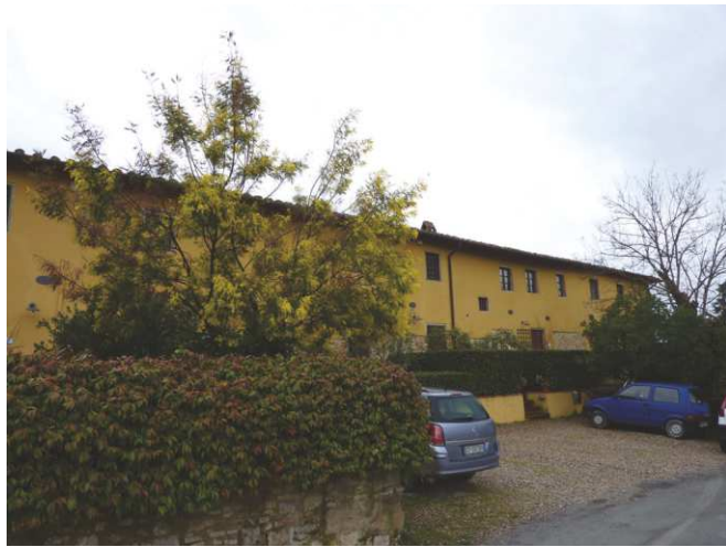
FOTO 1 - Rif. A - Il prospetto principale della colonica visto dalla strada
