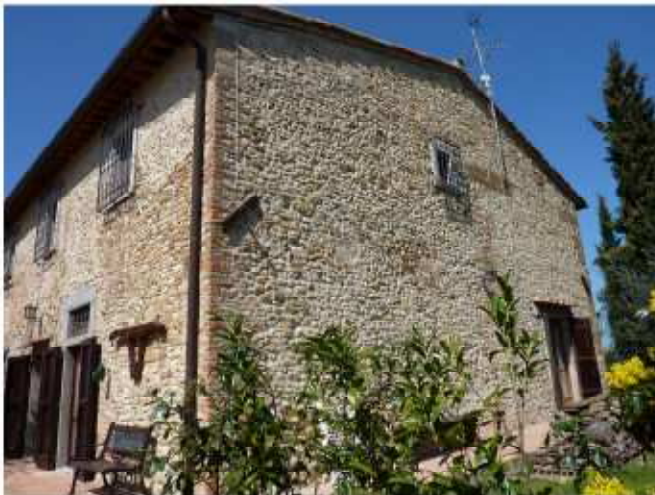
FOTO 4 - Rif. A - Prospetto laterale orientale
