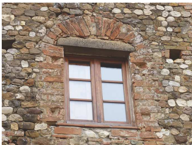
FOTO 4 - Rif. A - particolare dell'apertura al p1
