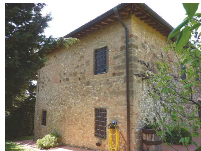
FOTO 3 - Rif. A - prospetto ad Est
