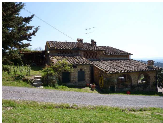
FOTO 4 - Rif. A - prospetto laterale a Nord - Est
