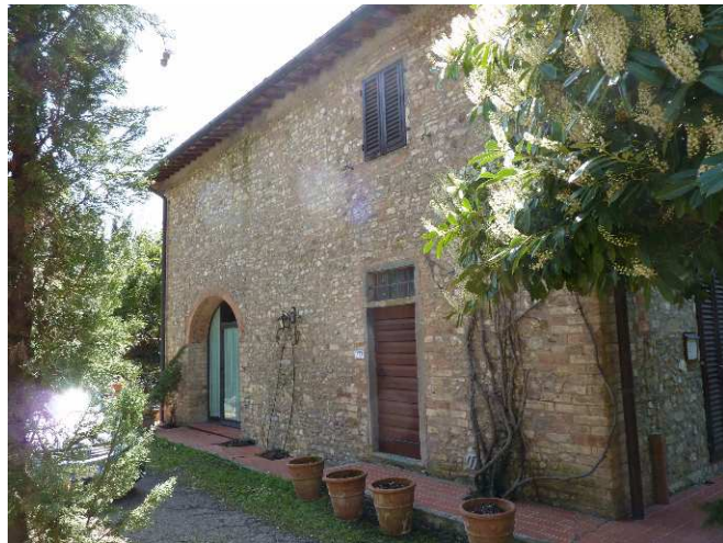
FOTO 4 - Rif. A - prospeto laterale a sud ovest
