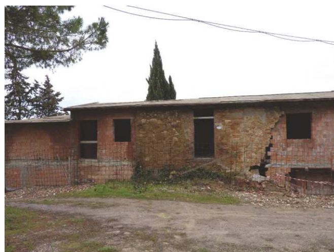
FOTO 2 - Rif. A - prospetto laterale ad Est
