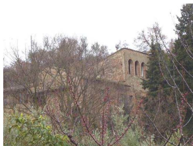
FOTO 5 - Rif. A - Il prospetto opposto a quello su strada
