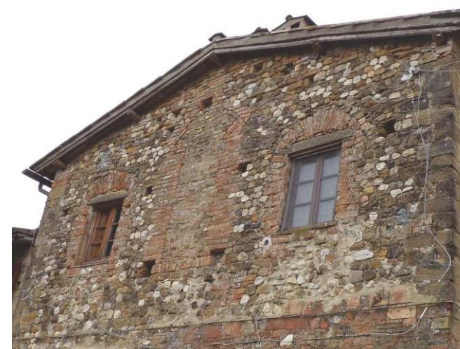
FOTO 3 - Rif. A - aperture del piano1 - fronte principale
