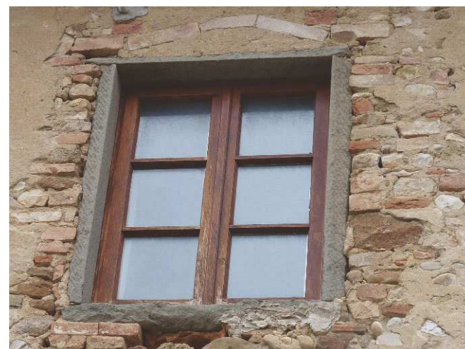
FOTO 2 - Rif. A - una delle finestre che guardano sull'aia con le cornici in pietra
