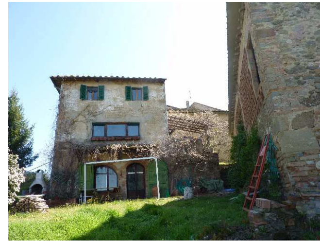
FOTO 3 - Rif. A - Il prospetto laterale verso ovest
