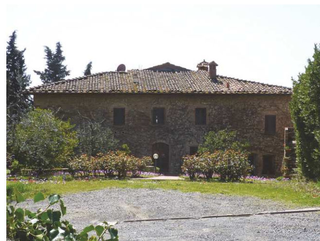
FOTO 2 - Rif. A - prospetto laterale a Nord
