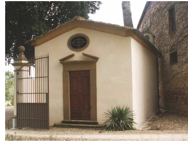
FOTO 3 - Rif. A - veduta del fronte principale
