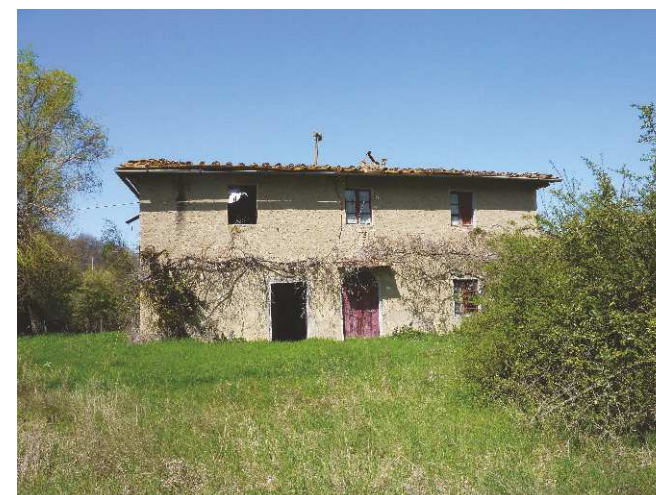
FOTO 3 - Rif. A - Il prospetto principale
