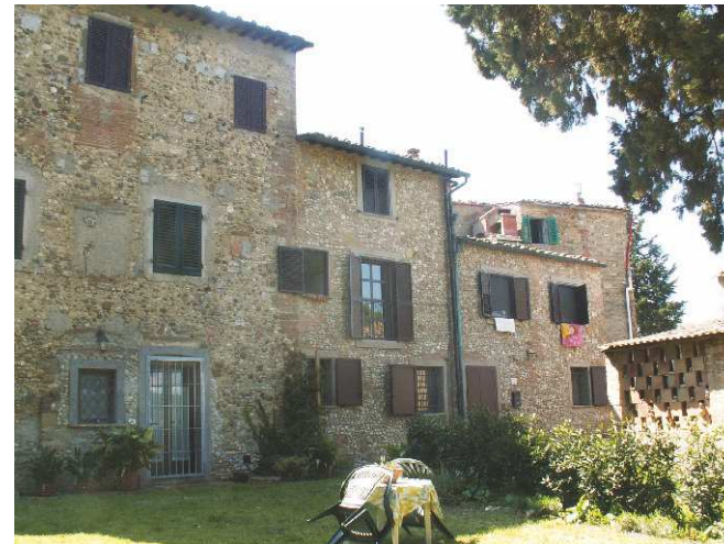
FOTO 4 - Rif. A - La parte ovest del retro dell'edificio
