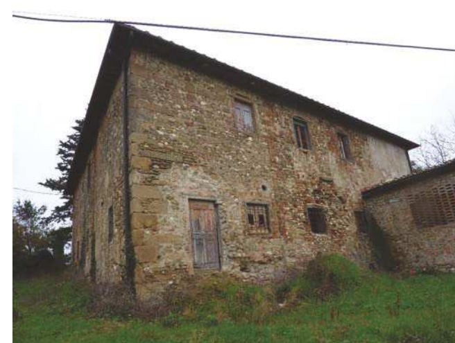
FOTO 6 - Rif. A - Il prospetto opposto all'ingresso con il rustico giustapposto perpendicolare all'edificio principale
