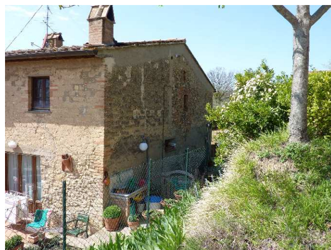
FOTO 2 - Rif. A - Il prospetto laterale nord
