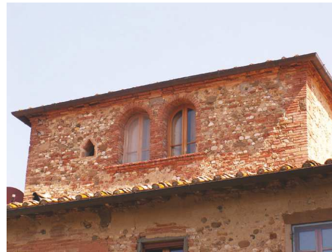
FOTO 5 - Rif. A - particolare del torrino
