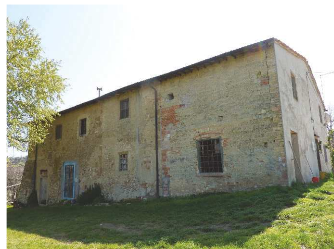
FOTO 2 - Rif. A - Il prospetto laterale nord
