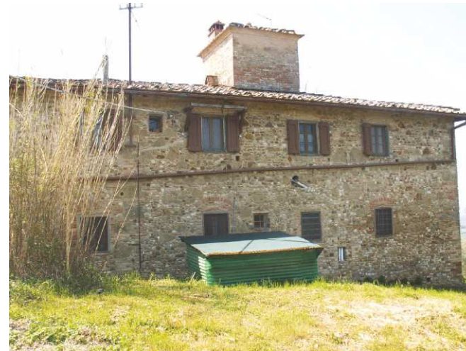
FOTO 5 - Rif. B - veduta del fronte della dependance
