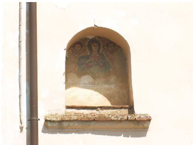
FOTO 7 - Rif. A - Particolare della nicchia presente sul prospetto principale su strada
