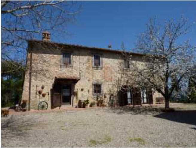
FOTO 1 - Rif. A - Il prospetto principale verso sud
