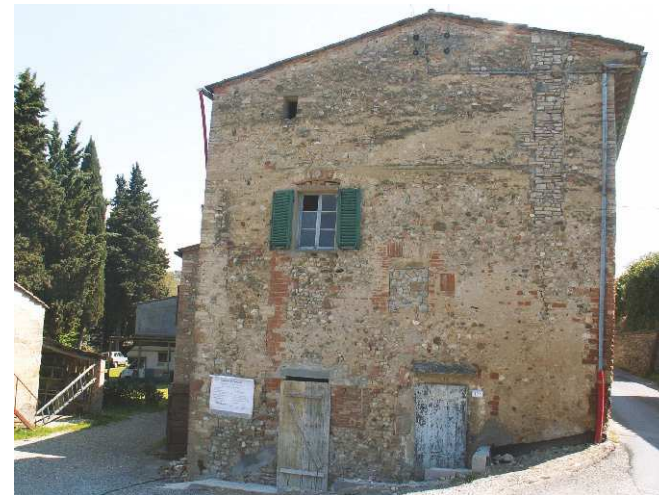
FOTO 5 - Rif. A - Prospetto occidentale
