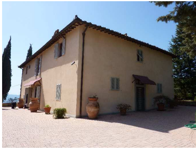
FOTO 1 - Rif. A - vista di scorcio da Nord - Est
