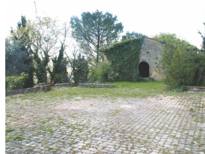
FOTO 6 - Rif. C - veduta del fronte
