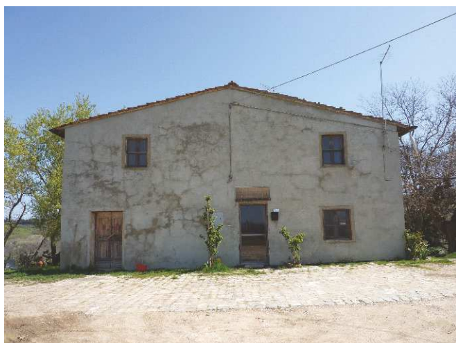
FOTO 1 - Rif. A - Il fronte principale timpanato
