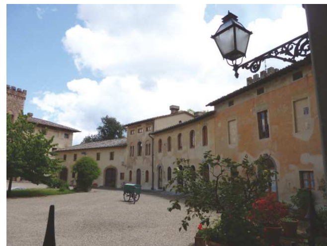
FOTO 8 - Rif. A - veduta della corte interna
