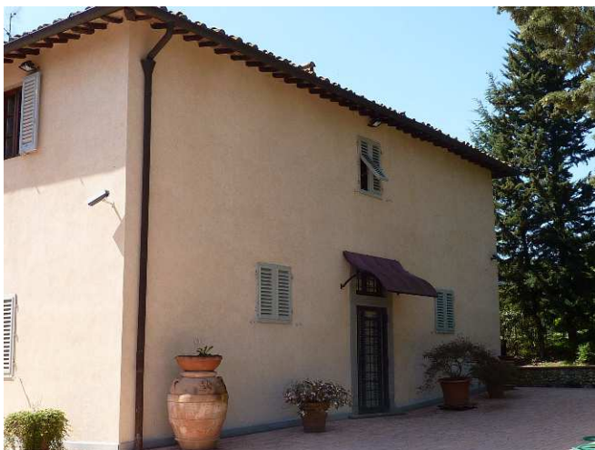
FOTO 7 - Rif. A - edificio prospetto a Nord- Est
