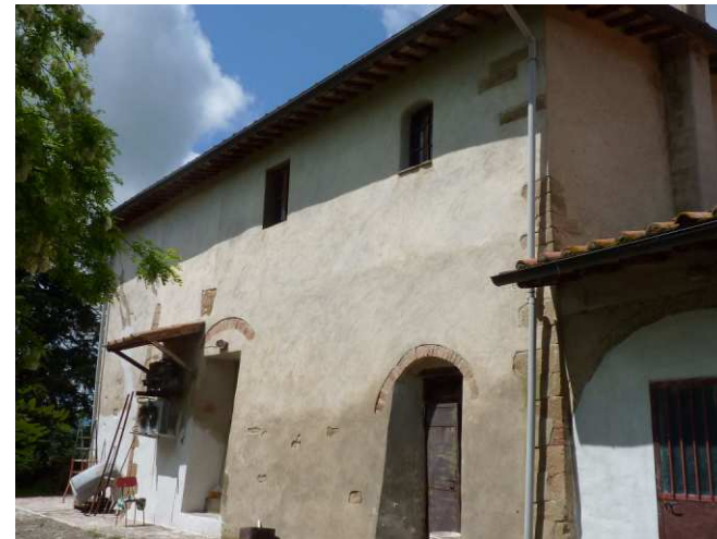
FOTO 5 - Rif. A - prospetto del retro a Est
