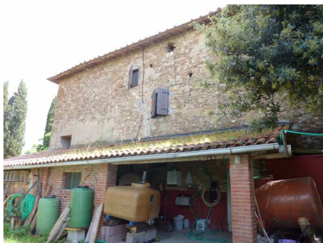
FOTO 4 - Rif. A - veduta del retro a Nord
