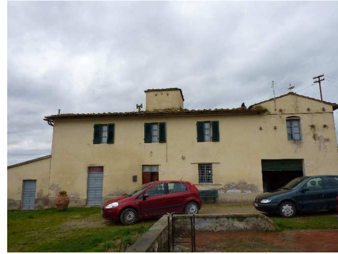
FOTO 2 - Rif. A - Il prospetto con l'ingresso principale
