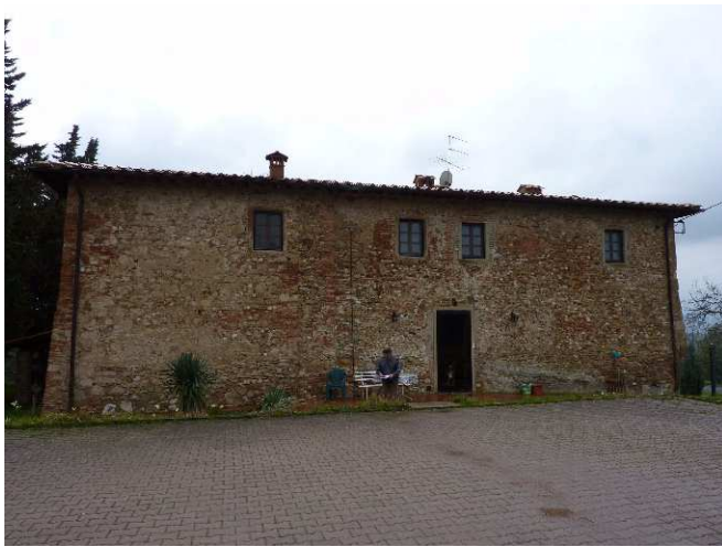
FOTO 1 - Rif. A - Veduta del fronte principale
