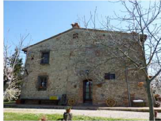
FOTO 2 - Rif. A - Il prospetto laterale ovest
