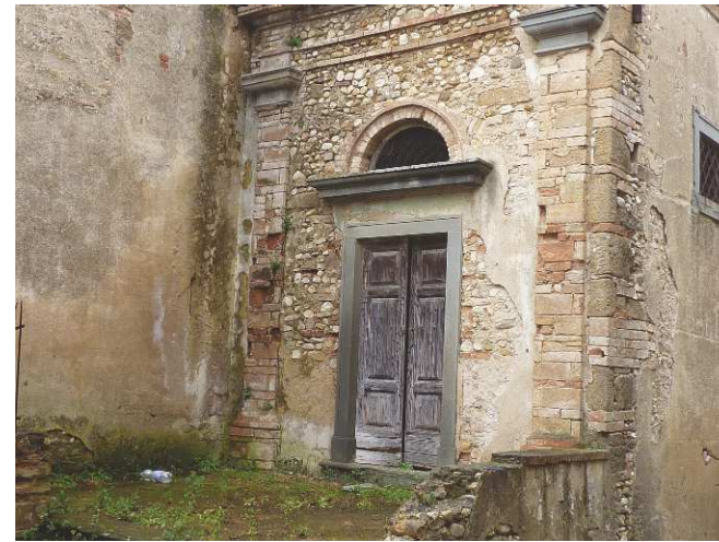
FOTO 2 - Rif. A - Il prospetto principale con l'ingresso
