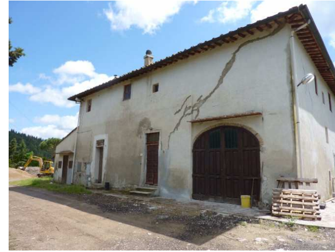
FOTO 3 - Rif. A - fronte principale a Ovest
