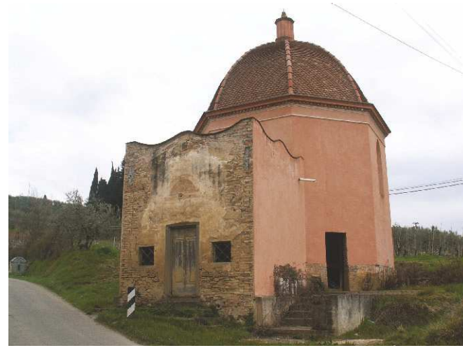
FOTO 2 - Rif. A - veduta del fronte da Ovest
