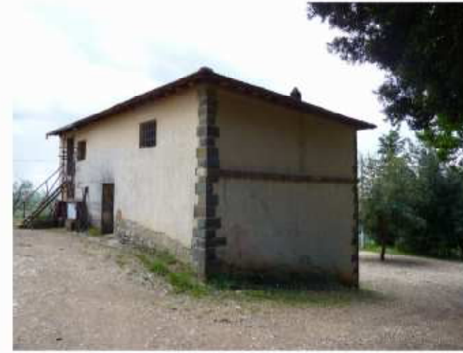
FOTO 12 - Rif. C - prospetto del fronte e del lato dx
