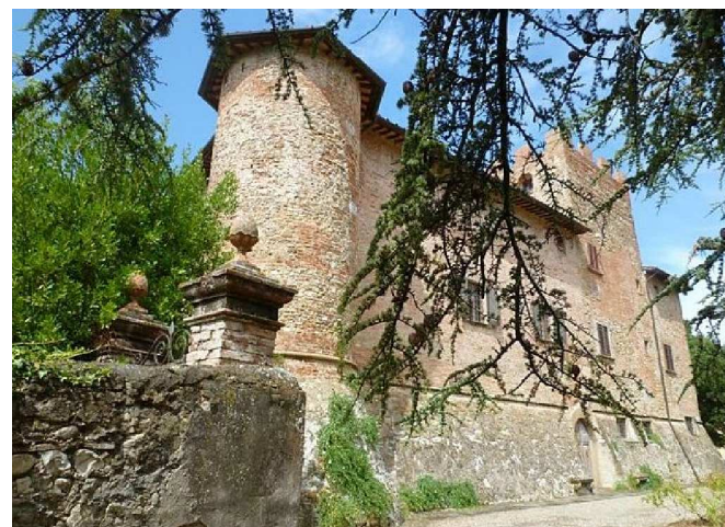
FOTO 2 - Rif. A - veduta del fronte del castello
