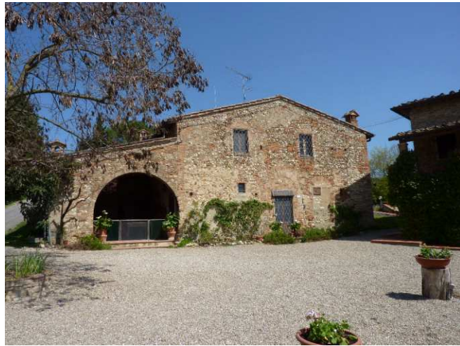
FOTO 1 - prospetto principale a Sud - Ovest
