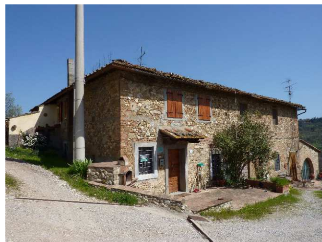
FOTO 2 - Rif. A - Il prospetto principale verso ovest
