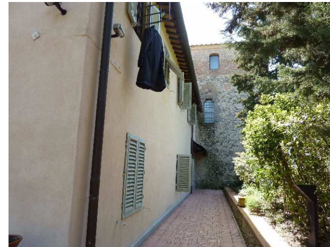
FOTO 6 - Rif. A - edificio prospetto a Nord
