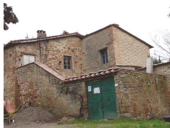
FOTO 4 - Rif. A - Il prospetto che in origine era timpanato e a cui è stato successivamente aggiunta la volumetria sulla destra
