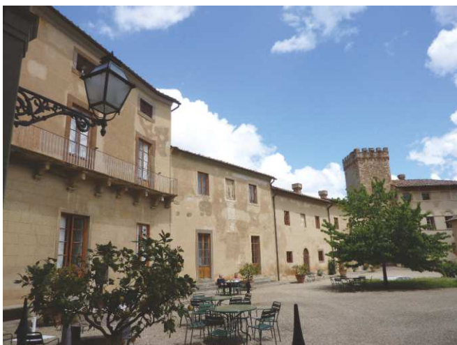
FOTO 7 - Rif. A - veduta della corte interna
