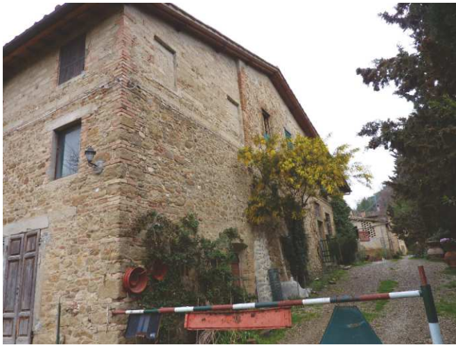
FOTO 4 - Rif. A - veduta della testata a Sud- Est
