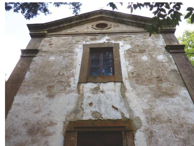
FOTO 9 - Rif. B - veduta del fronte della cappella
