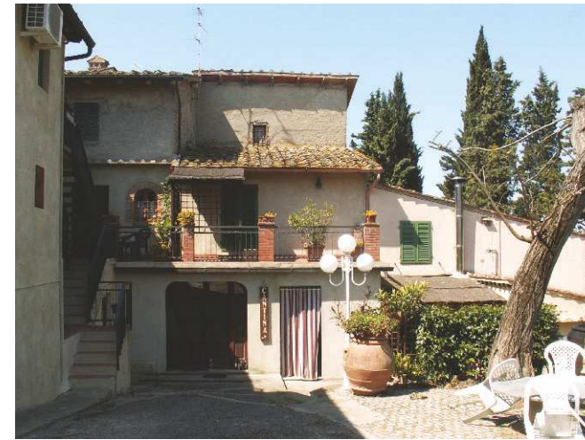
FOTO 3 - Rif. A - Parte del lato nord dell'edificio
