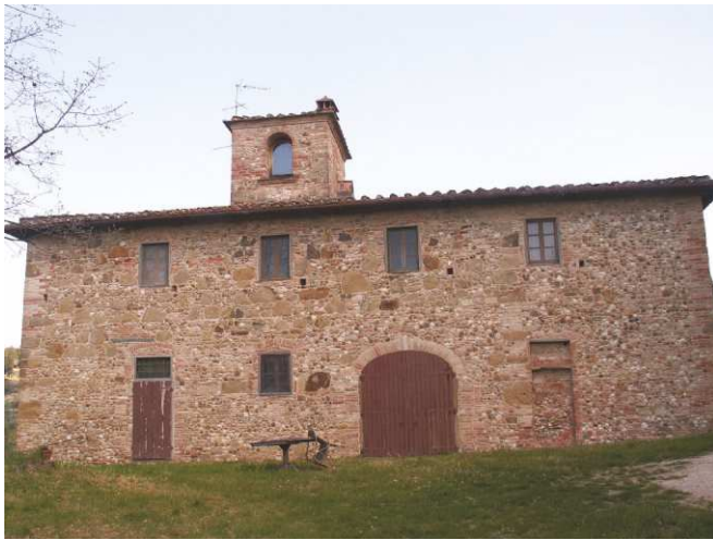
FOTO 1 - Rif. A - Veduta del fronte
