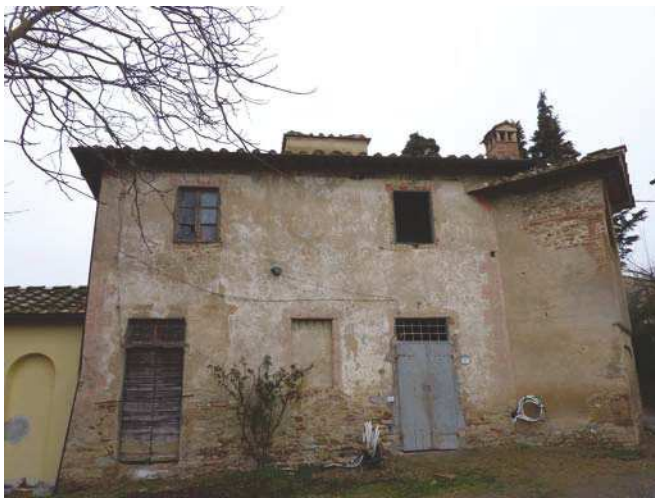
FOTO 1 - Rif. A - La facciata meridionale
