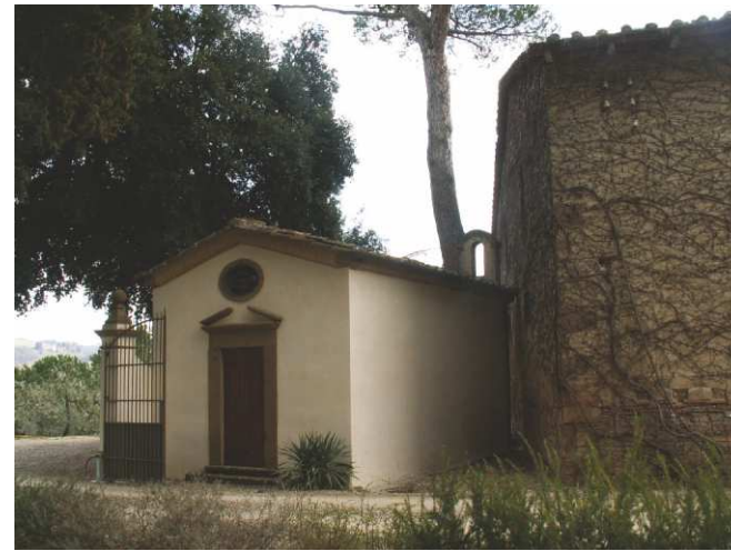
FOTO 2 - Rif. A - veduta Nord dell'ingresso e della chiesa
