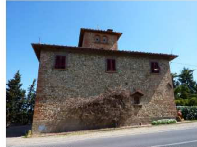
FOTO 3 - Rif. A - Propetto ovest, quello che si affaccia direttamente sulla strada provinciale
